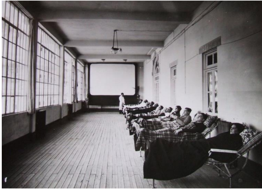
Foto 24 – Galeria de cura no Grande Sanatório, com o ecrã de cinema no fundo, anos 1930. FONTE: fotografia (s. d.), coleção particular. Reprodução da autora.
