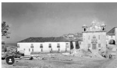
Figura 70: Obras na Alta, ainda sem a Faculdade de Letras Fonte: https://www.instagram.com/old_coimbra/
