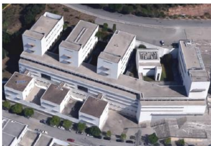
Figura 12 - Edifício do DEEC [37]
