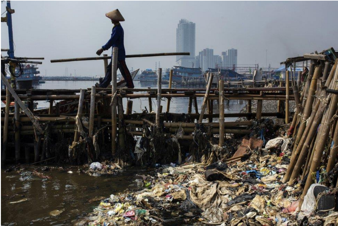
Figura 4 - Lançamento inadequado de resíduos
