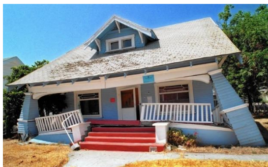
Figura 1.1 – Estruturas sem capacidade para resistir à ação sísmica a) habitação em Fillmore, 1994. b) Cypress Freeway, Oakland, 1989.
