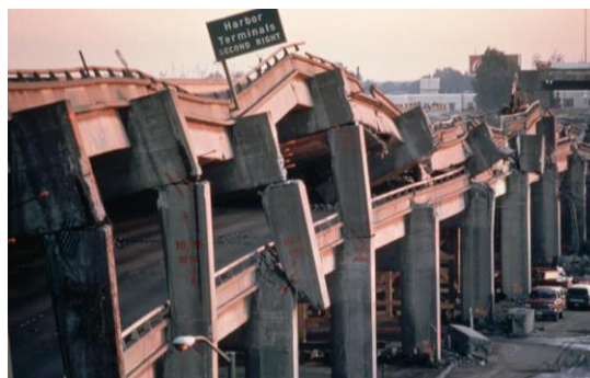
Figura 1.1 – Estruturas sem capacidade para resistir à ação sísmica a) habitação em Fillmore, 1994. b) Cypress Freeway, Oakland, 1989.
