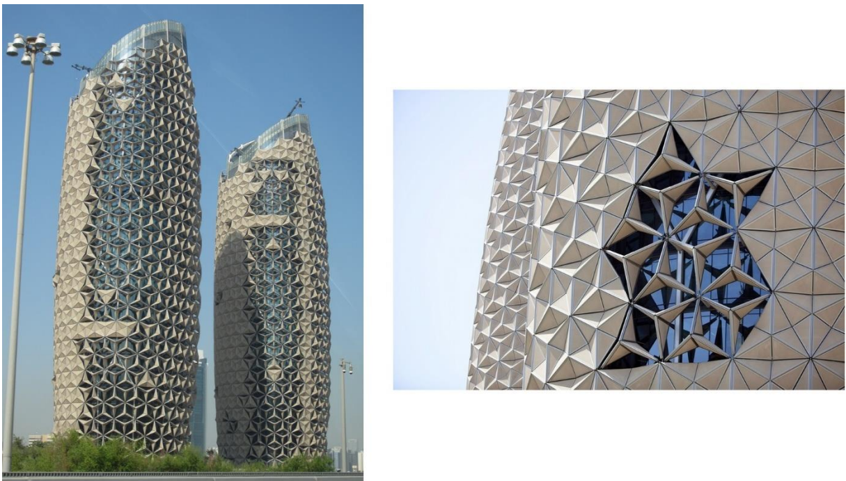
Figura 2.15. Sistemas de sombreamento reativo aplicado nas Torres Al-Bahr, Abu Dhabi (@livinspaces, 2020; @blogdaarquitectura, 2020).
