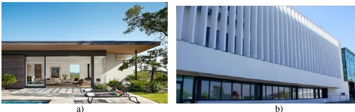
Figura 2.12. Dispositivos fixos de sombreamento exteriores: a) Pala horizontal (@gardenista); b) Palas verticais (@archiexpo).
