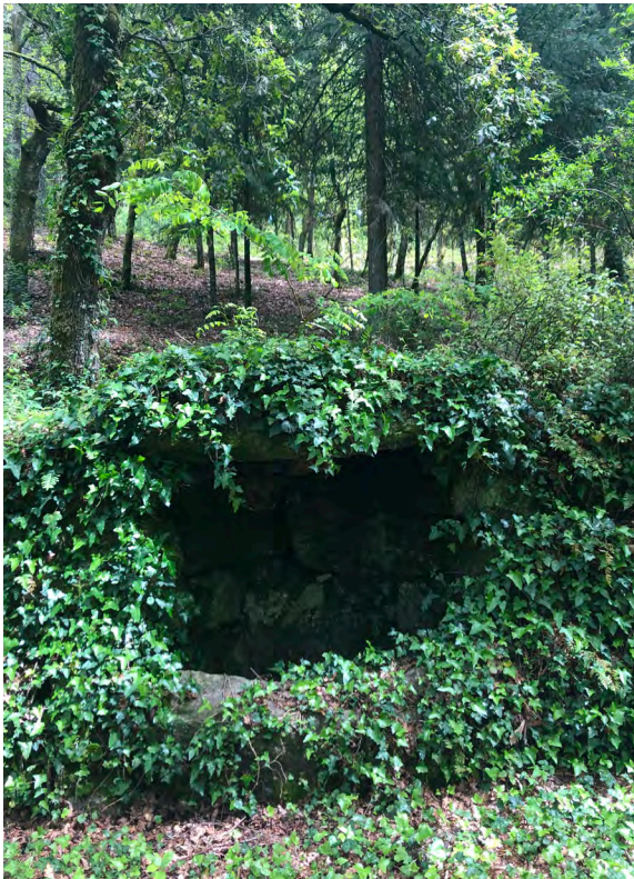
Antigo poço coberto de heras
