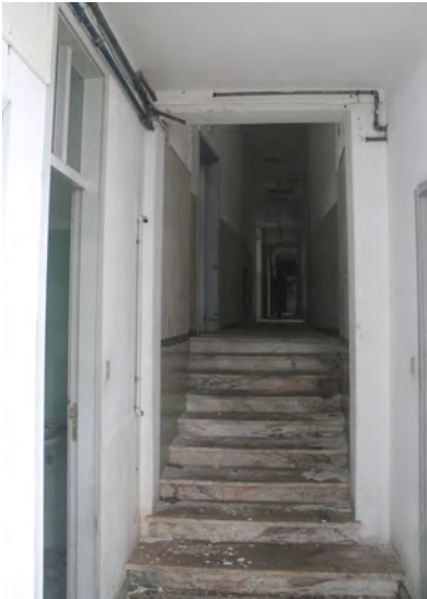
Fig. 120- Corredor central do piso térreo (fotografia do autor)
