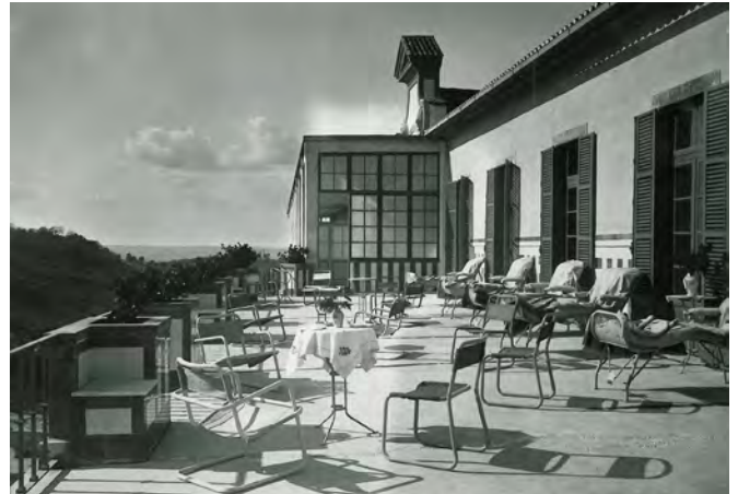
Fig. 106- Terraço - galeria sul (Nunes, J. C. R. A. (2017). A arquitectura dos sanatórios para a tuberculose em Portugal: 1850-1970. Dissertação de Doutoramento em Arquitectura. Universidade de Coimbra, Coimbra, Portugal. Vol. II. P. 888)
