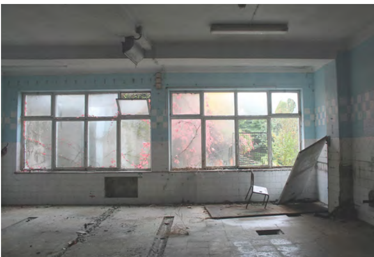
Fig. 118- Sala sudeste do primeiro piso (fotografia do autor)
