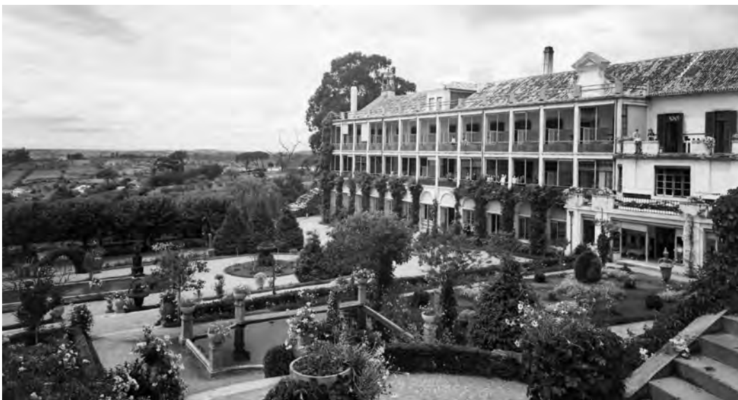
Fig. 15 - Galeria sul do Sanatório de Celas
