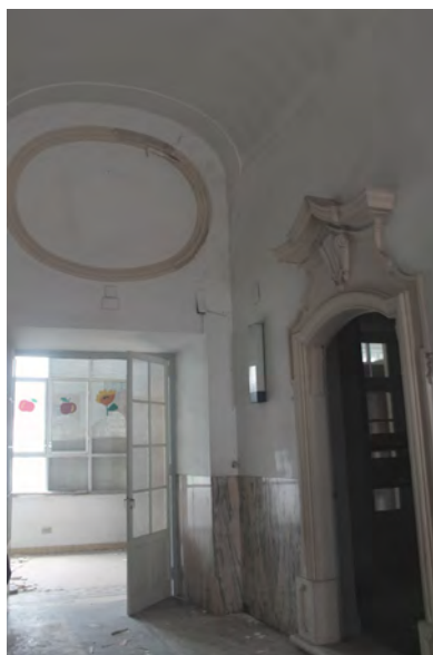
Fig. 127- Entrada da capela, 2º piso (fotografia do autor)
