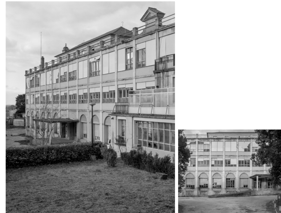
Fig. 19/20 - Alçado sul do Hospital Pediátrico (no estado atual de desocupação)
