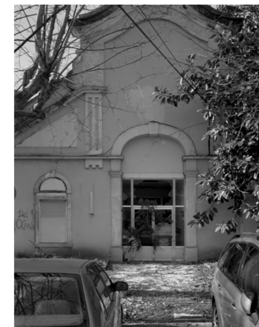
Fig. 22 - Alçado nascente do Hospital Pediátrico (no estado atual de desocupação)
