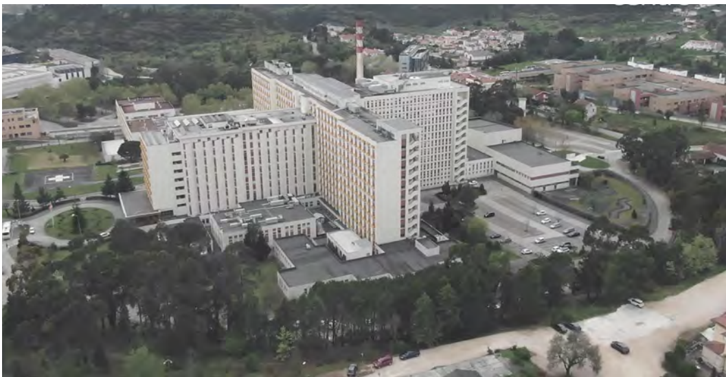
Fig. 34 - Vista aérea de nascente do CHUC
