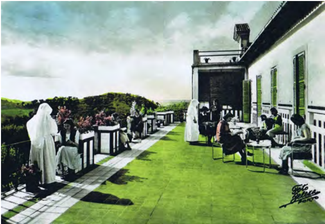
Fig. 105- Terraço- galeria sul (Nunes, J. C. R. A. (2017). A arquitectura dos sanatórios para a tuberculose em Portugal: 1850-1970. Dissertação de Doutoramento em Arquitectura. Universidade de Coimbra, Coimbra, Portugal. Vol. II. P. 888)
