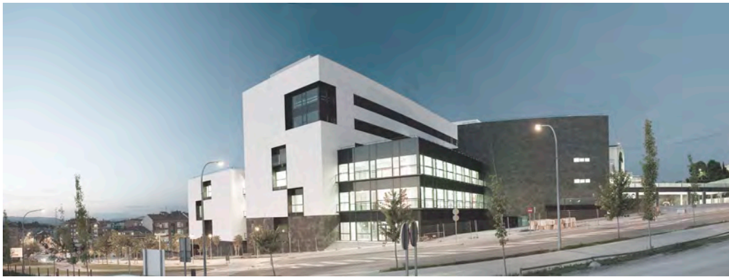
Fig. 47 - Vista da ampliação do Hospital Sant Joan de Déu
