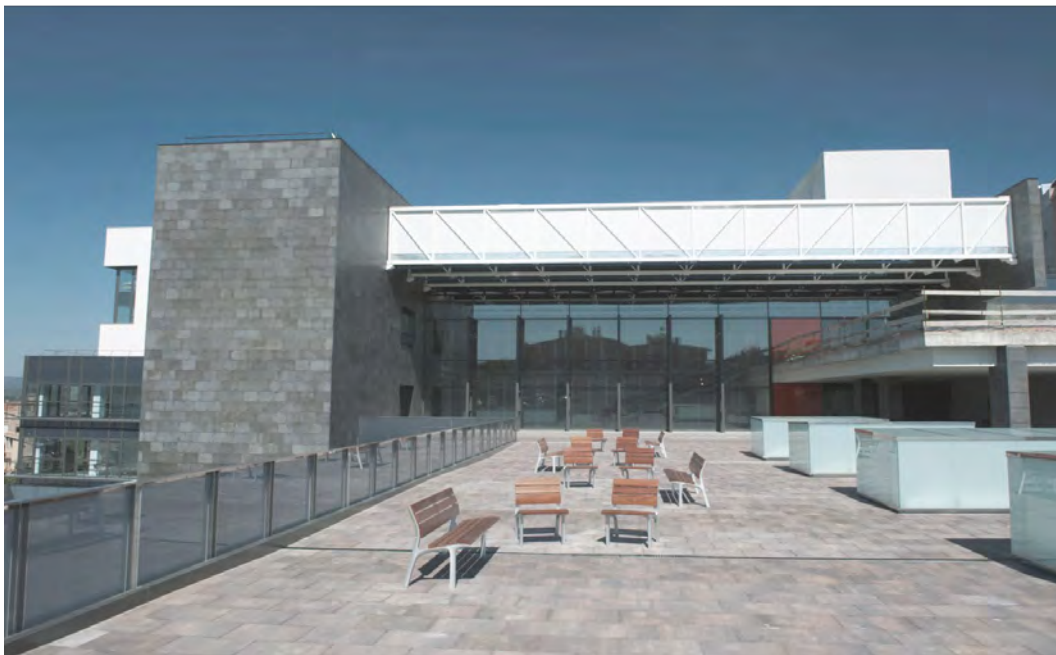
Fig. 48 - Vista da entrada no novo piso térreo - piso 0
