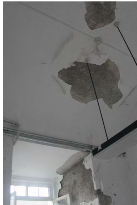
Fig. 85- Estado atual das paredes a reabilitar
