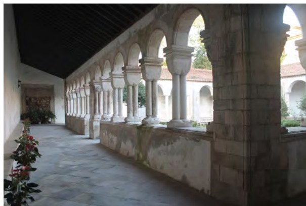
Fig. 31 - Vista interior do Claustro do Mosteiro de Celas
