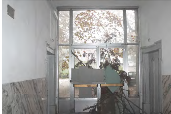
Fig. 82- Estado atual da entrada no piso 2
