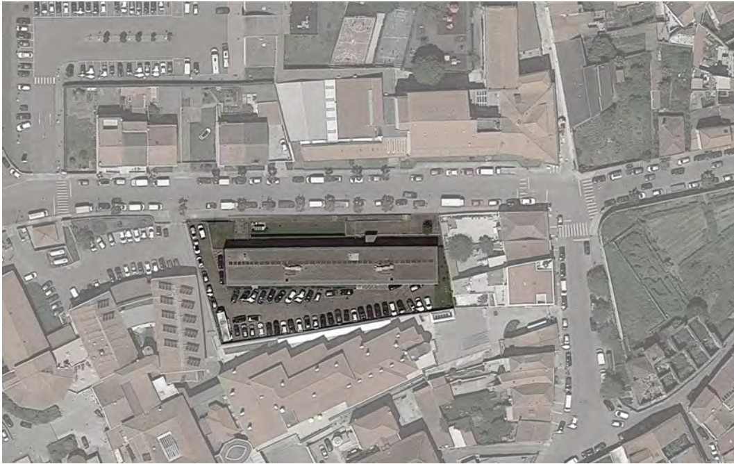
Fig. 49 - Vista aérea da implantação do Centro de Saúde
