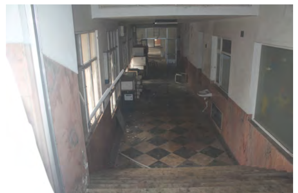
Fig. 119- Galeria Sul do piso térreo (fotografia do autor)
