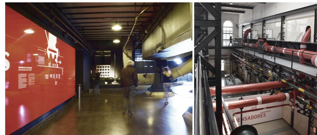
Fig. 109: Sala dos Cinzeiros [esq.] e Sala dos Condensadores [dir.] com pé direito duplo, entre as quais as dimensões altimétricas variam bastante
