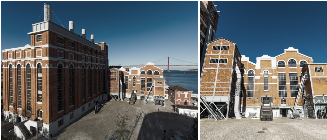
Fig. 48: Museu da Eletricidade atualmente
