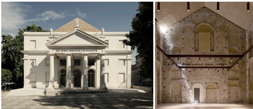
Fig. 31: Teatro Thalia (Gonçalo Byrne Architects & Barbas Lopes Architects, 2008, Lisboa), projeto de reconversão e ampliação do antigo teatro devastado pelo fogo Fonte: https://www.archdaily.com.br/br/783962/teatro-thalia-goncalo-byrne-architects-and-barbas-lopes-architects , consultado em 24/06/2018
