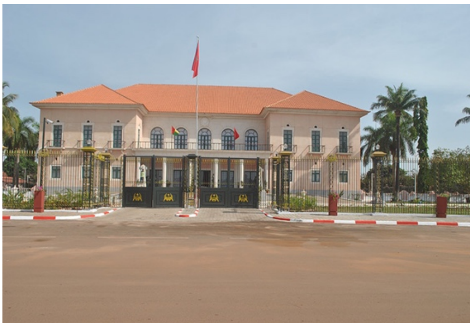
Figura 28 – Palácio da República (Bissau), após intervenção de reabilitação
