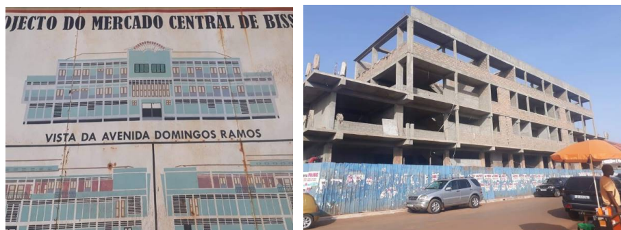
Figura 33 – Mercado Central (Bissau), projeto (fachada) e obras a decorrer
