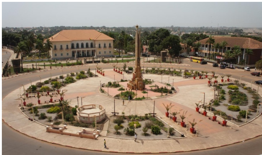
Figura 29 – Praça dos Heróis Nacionais (Bissau), após intervenção de reabilitação
