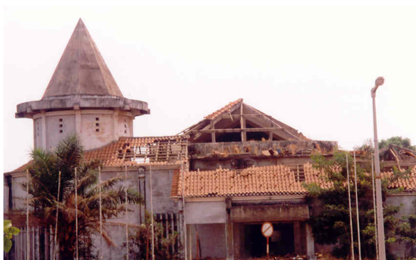
Figura 30 – Museu Etnográfico (Bissau), antes de intervenção de reabilitação
