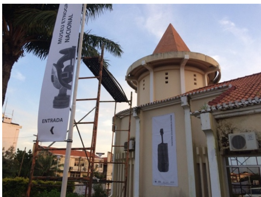
Figura 31 – Museu Etnográfico (Bissau), após intervenção de reabilitação
