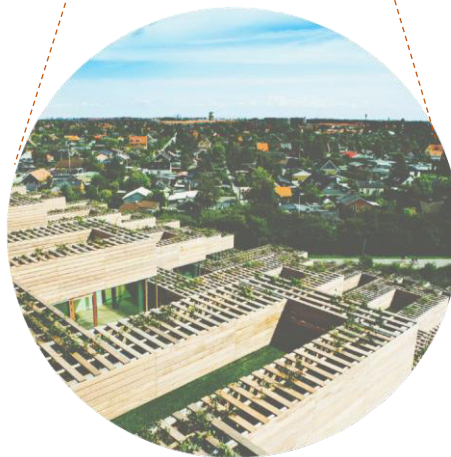
Figura 106: Vista de um dos apartamentos para o lado Este
