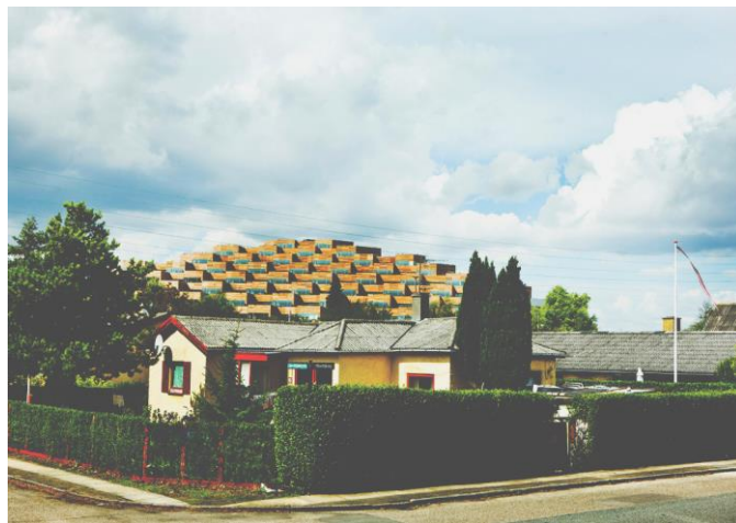
Figura 115: Vista para a zona das habitação e coberturas ajardinadas; lado Este
