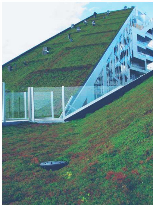
Figura 130: Coberturas ajardinadas da 8House e sistema de manutenção
