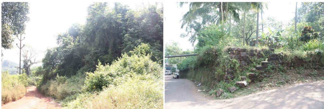
Imagens 2.04 e 2.05 À esquerda: Forte e Passo de São Tiago de Benasterim; à direita: Baluarte e Passo Seco de Gandaulim.
