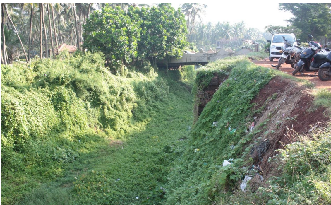
Imagem 4.30 Praça da Aguada: fosso, a norte, parcialmente desmoronado; ao fundo, a ponte, reconstruída recentemente.
