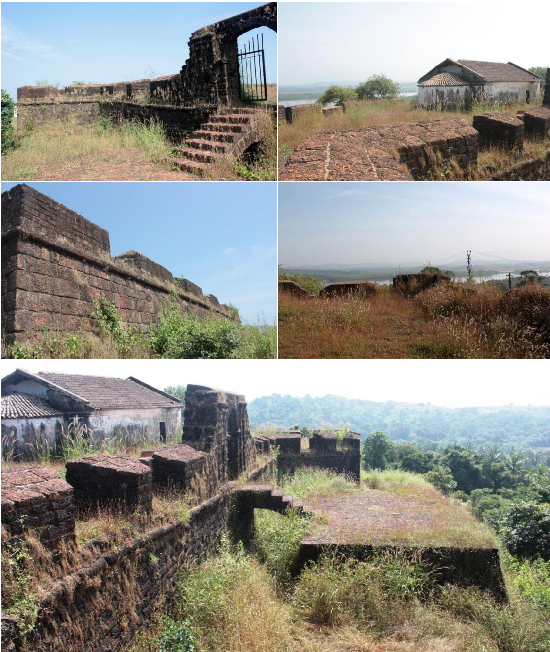
Imagens 3.46 a 3.50 Forte de Santo Estêvão.
