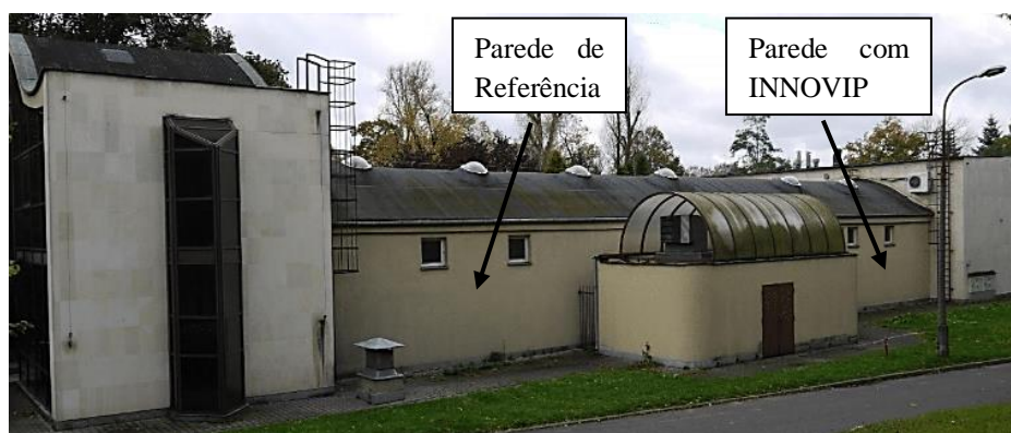
Figura 2.4 – Identificação das paredes de Referência e com INNOVIP.
