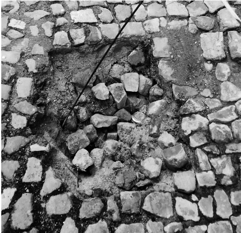
Figure 61: A pothole/sinkhole on R. 15 de Março awaiting repair.
