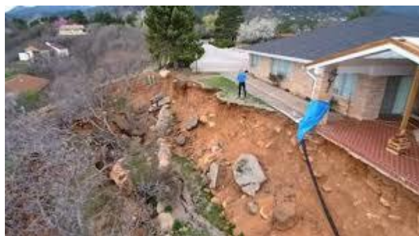
Figura 1.2 – Rotura do solo numa habitação no estado do Colorado (Capital Geotechnical Services PLLC).
