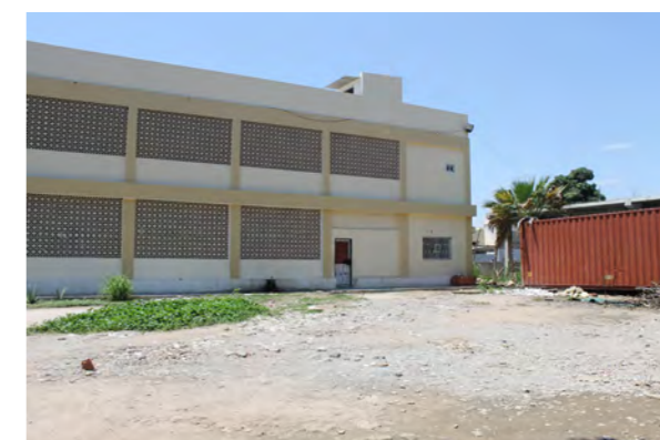
Fig. 129 e 130 Aspeto incompleto da obra.
