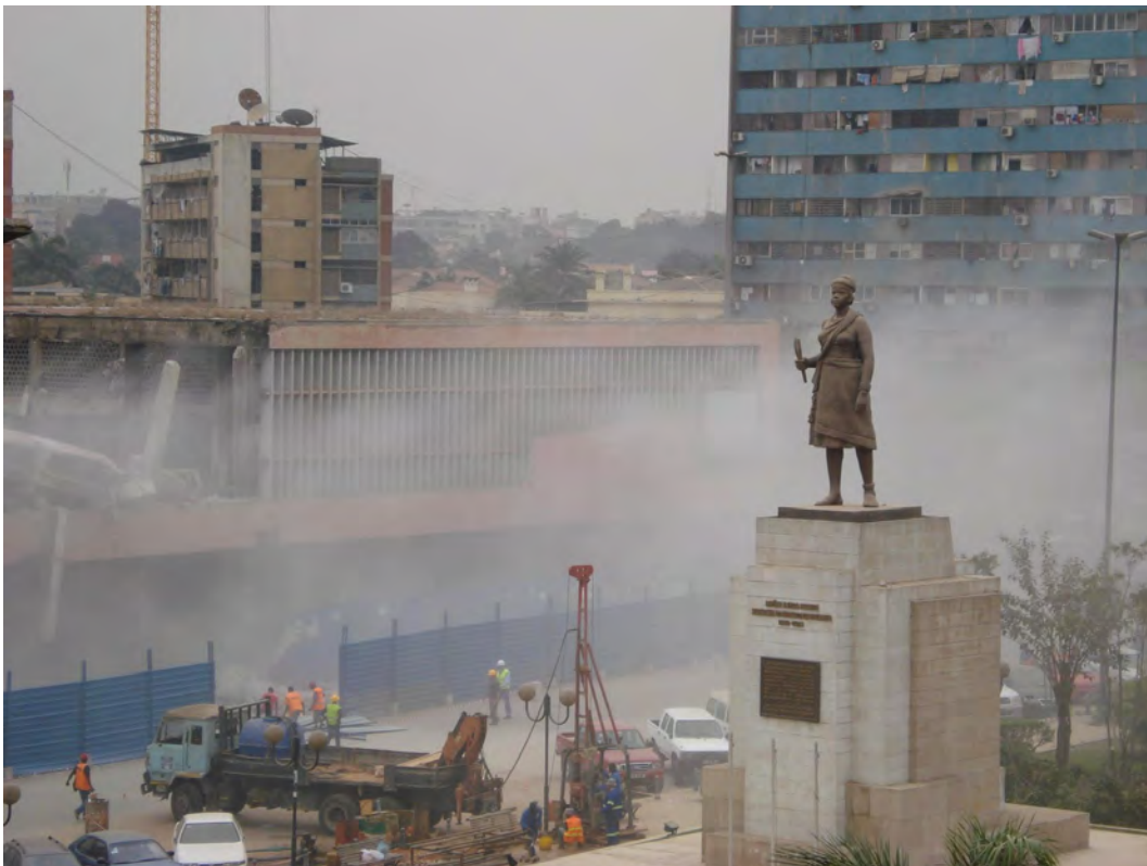
Fig. 62 Demolição do Mercado do Quinaxixe (2008).
