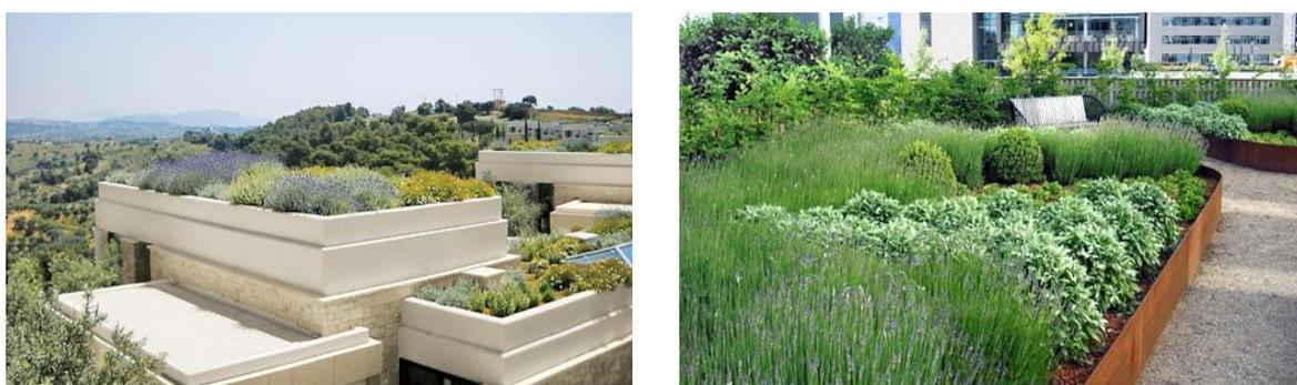
**Figura 10:** Cobertura Semi-Intensiva. (Fonte: Zinco, 2019).
