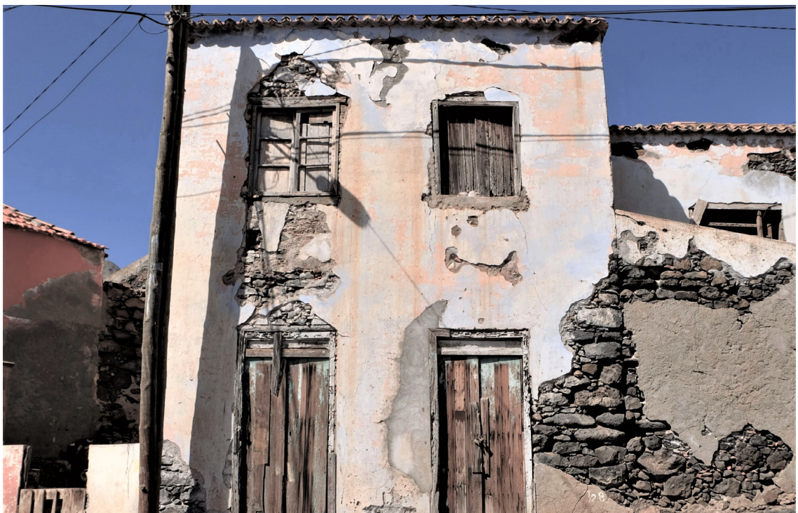
Edifício 2, desabitado, Preguiça, São Nicolau. De José Mesquita
