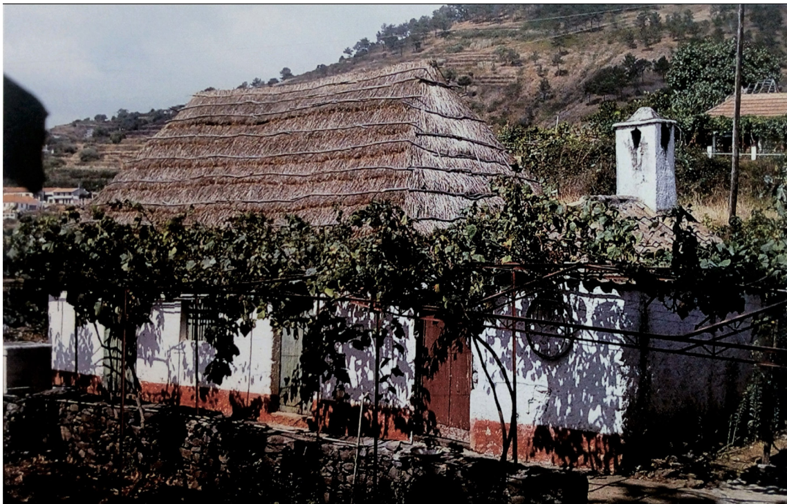
Habitação com cobertura em palha, Caniço, Madeira. In Arquitectura Popular na Madeira (Mestre, 2002: 105)
