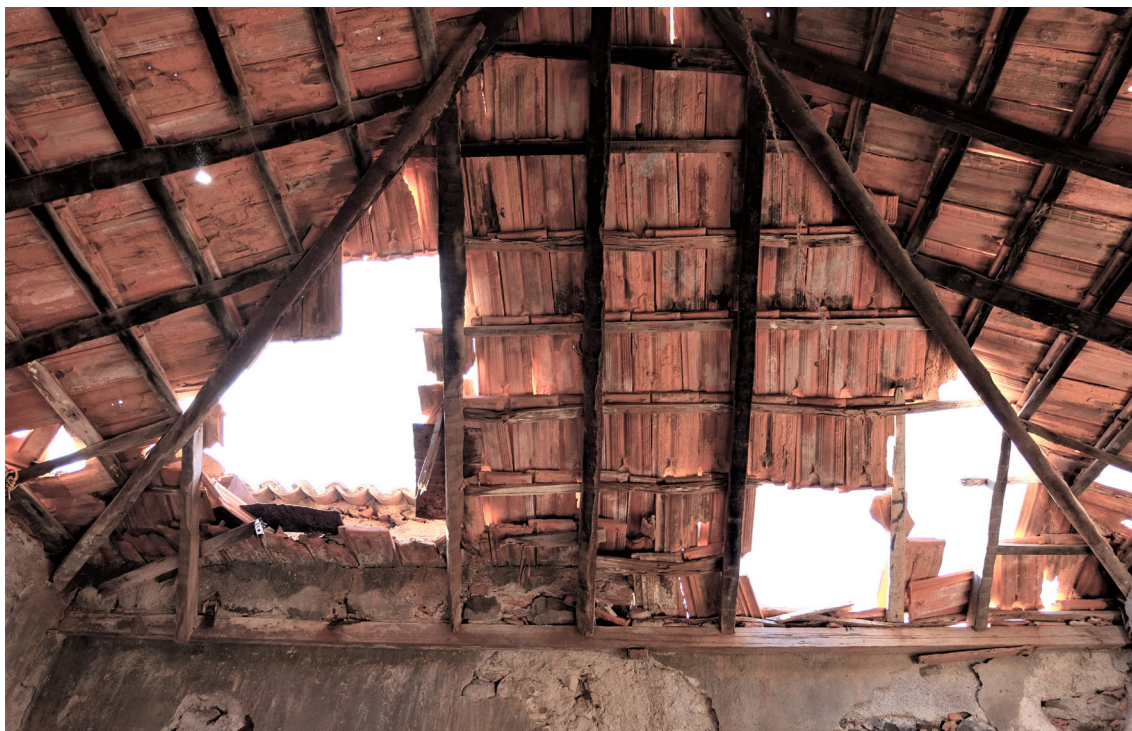
Cobertura do edifício 3, Preguiça, São Nicolau. José Mesquita
