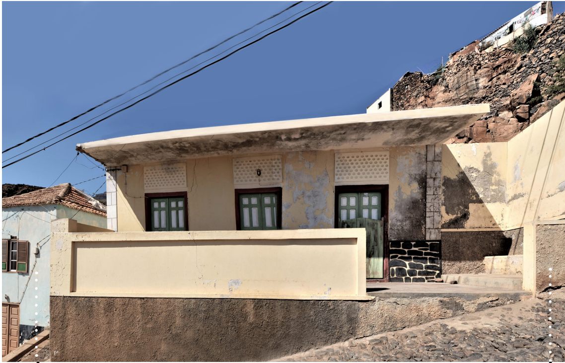
Edifício 5, desabitado, Preguiça, São Nicolau. De José Mesquita
