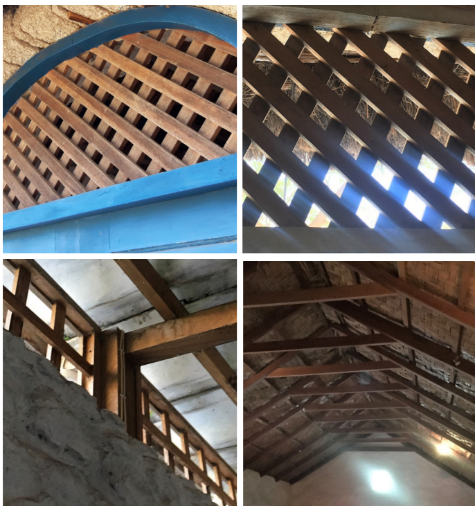
Referências de estruturas para ventilação e coberturas, Santo Antão. António Lopes e Philippa Remhof
