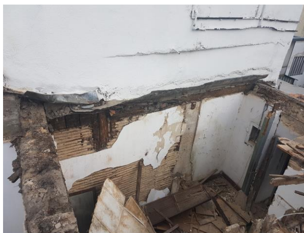
Figura 43 – Parede de tabique a demolir
