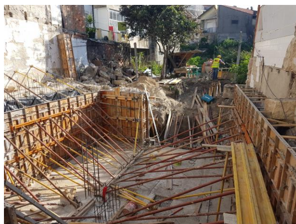
Figura 48 - Planta de fundações (Arquitetude, 2017) Figura 49 – Betonagem de muros periféricos
