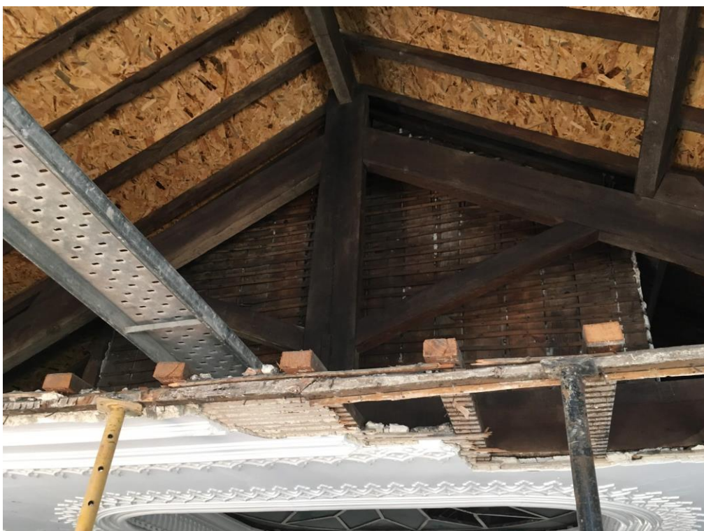
Figura 27 - Parede de tabique antes de reforço com placa de OSB 3
