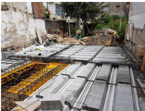
Figura 50 - Laje aligeirada do piso 0
