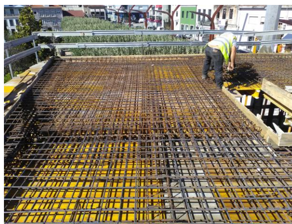
Figura 51 - Laje maciça do piso 2
