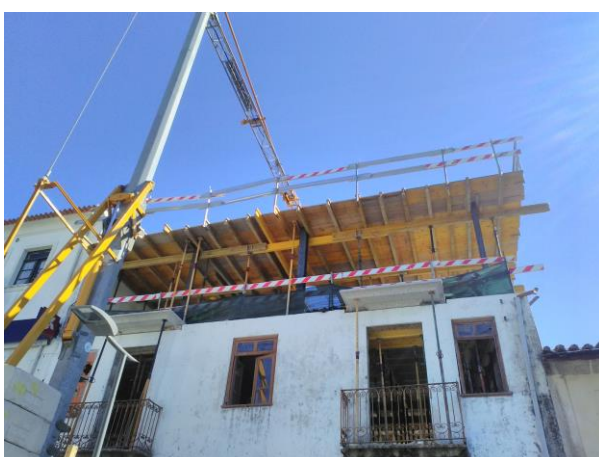
Figura 46 – Betonagem de novo piso
