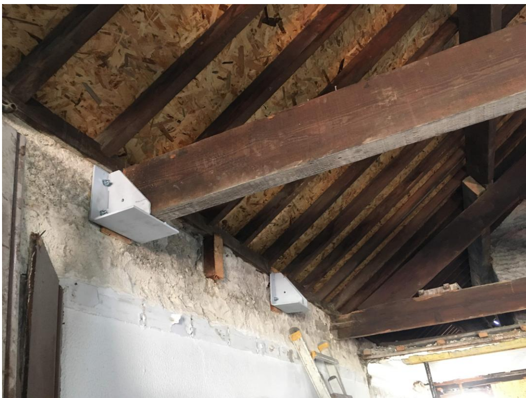
Figura 24 - Pormenor de ligação com sapata metálica
