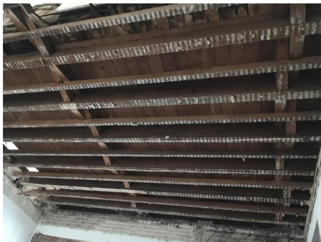
Figura 13 – Estrutura dos pisos de madeira
