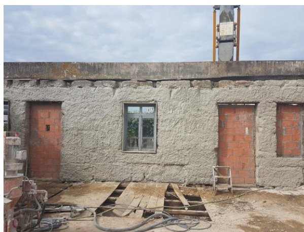
Figura 42 – Estrutura de pisos existentes a demolir
