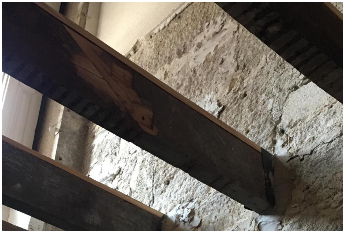
Figura 20 - Pormenor com entalhe a 45° reaproveitando vigamentos existentes
