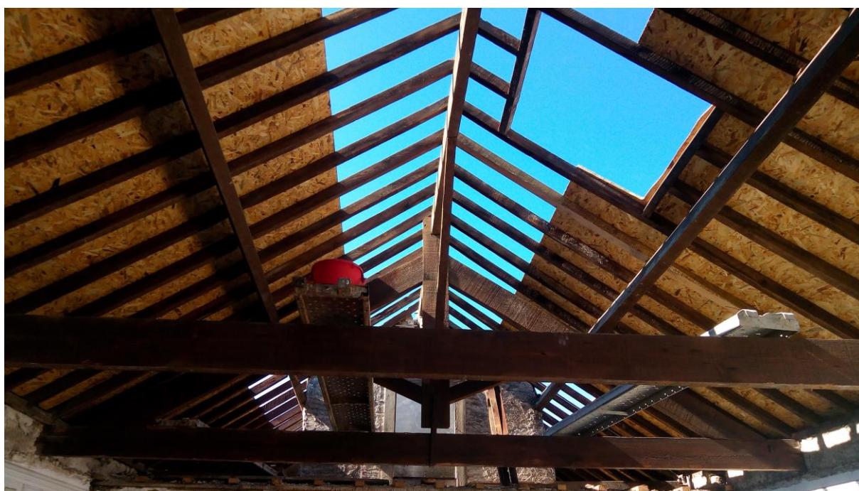
Figura 14 – Estrutura da cobertura em processo de reabilitação
