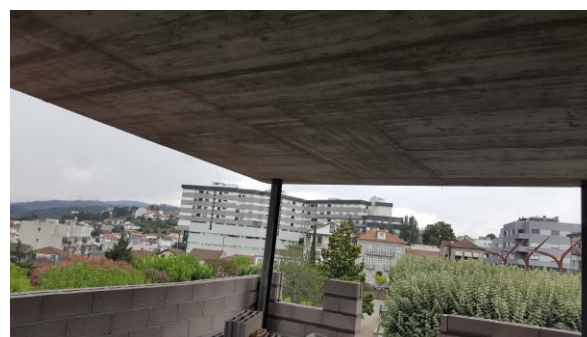
Figura 47 – Alvenarias em bloco de termoargila
