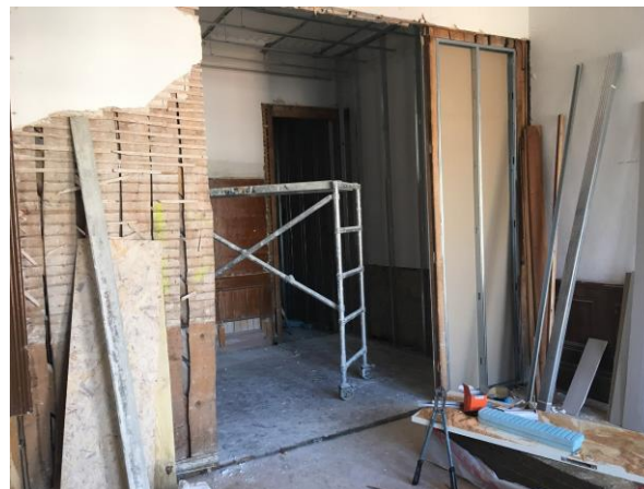
Figura 16 – Parede de tabique
