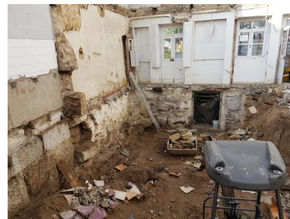
Figura 44 – “Miolo” demolido e fundação existente
