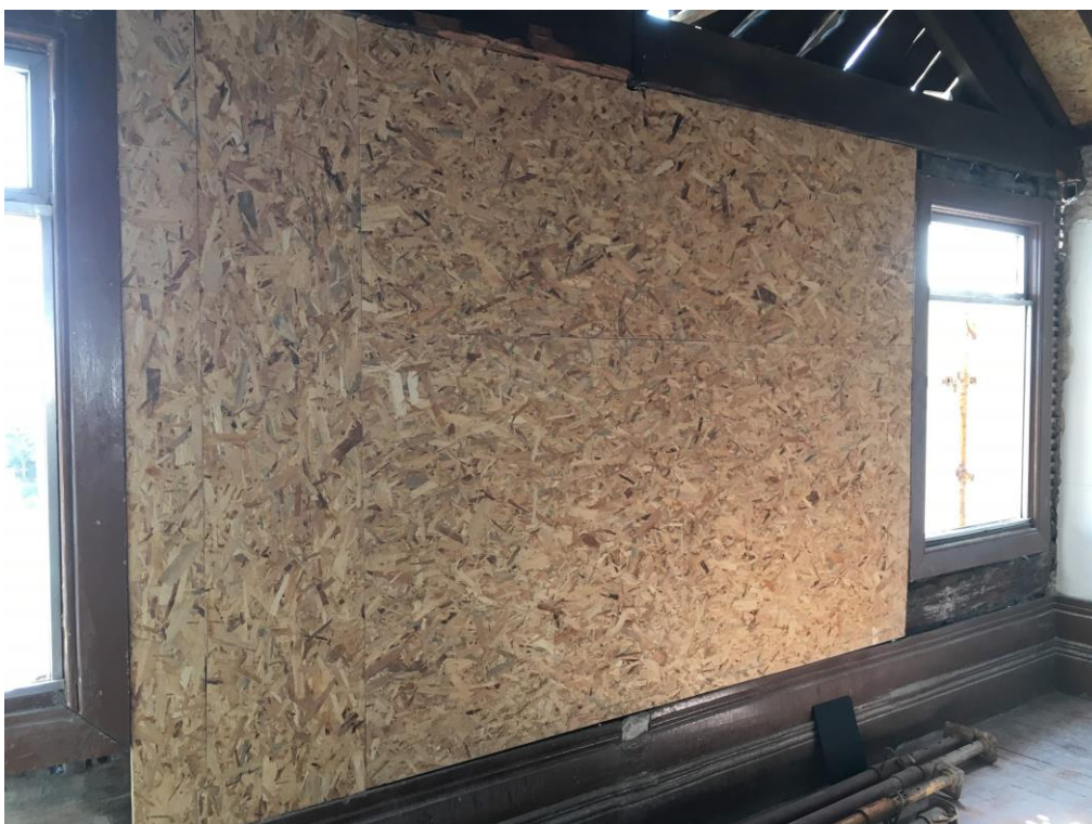
Figura 28 - Parede de tabique após reforço com placa de OSB3
