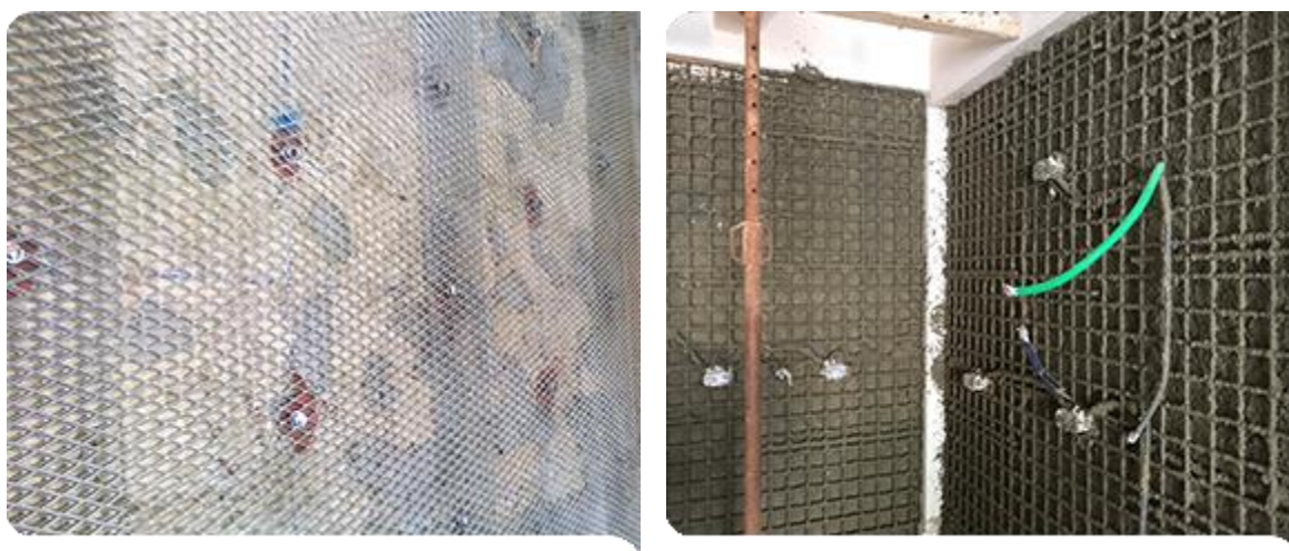
Figura 31 - Exemplo de aplicação da rede e projeção da primeira camada de microbetão (progepom.pt)
