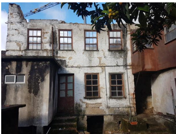
Figura 45 - Fachada posterior a ser demolida
