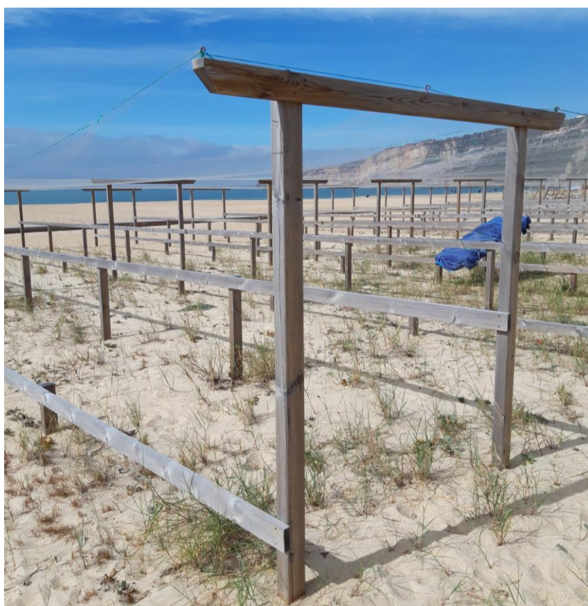
Figura 38 – As estruturas que formam o complexo de secagem são fabricadas em madeira de pinho e implantadas no terreno em lotes. É nestes lotes que o peixe é colocado a secar. (2019)
