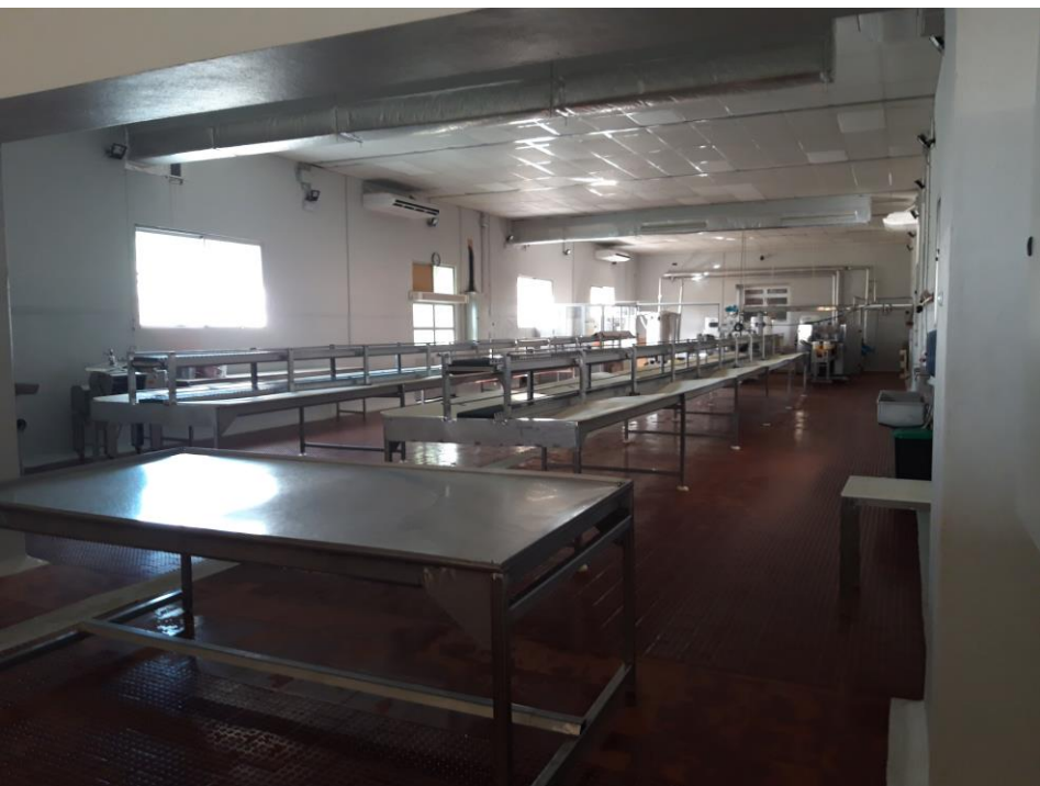
Figura 34 - Espaço interior da SUCLA, destacando equipamentos em aço inoxidável, pavimentos e revestimentos de parede em azulejo ou tijoleira para fácil limpeza. (2018)
