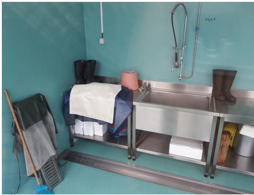
Figura 46 – Núcleo 3: equipamentos e escoamento revestidos em aço inoxidável, parede revestida até meia-altura com tinta hidrófuga e pavimento vinílico. (2019)
