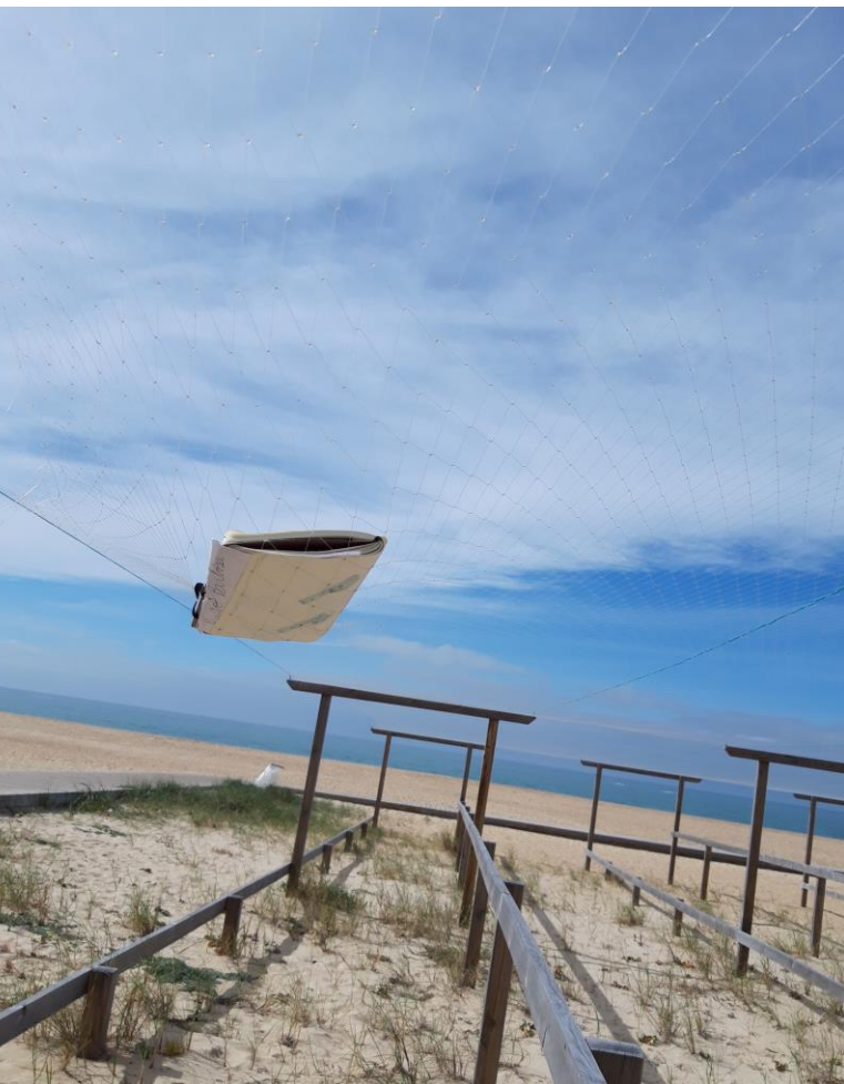
Figura 41 – As estruturas do complexo de secagem são revestidas por rede para proteger contra aves marítimas. (2019)
