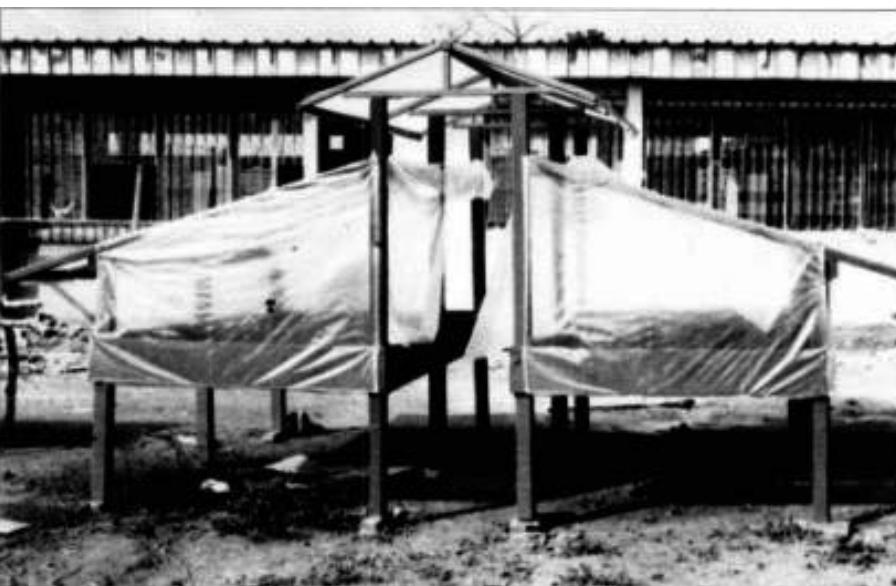
Figura 19 - Estufa de secagem solar simples (modelo da figura 18) (Bassey & Schimdt, 1986)
