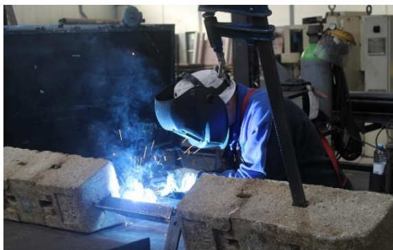
Figura 3.6 – Sobreposição das cantoneiras, execução da soldadura (a MAG) e limpeza.
