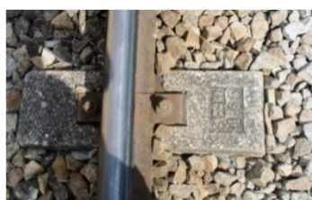
Figura 2.15 – Sistema de fixação RNP/PRX – fixação elástica.
