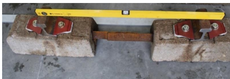
Figura 3.16 – Nivelamento transversal e alinhamento das TBB (BB2) adaptadas utilizando um nível e uma régua.
