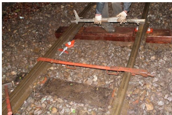
Figura A2.7 – Correção de bitola (se necessário).
