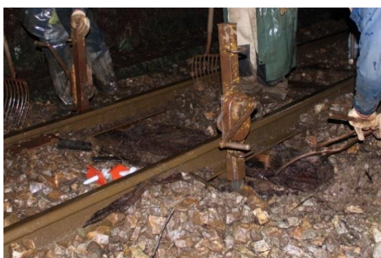
Figura A2.3 – Aplicação do macaco sobre o carril e substituição das travessas.
