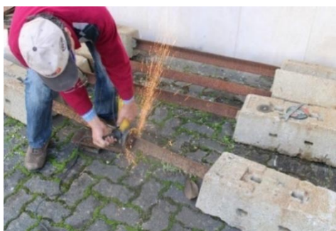
Figura A3.10 – Corte das amostras de provetes de cantoneira das TBB (BB2).
