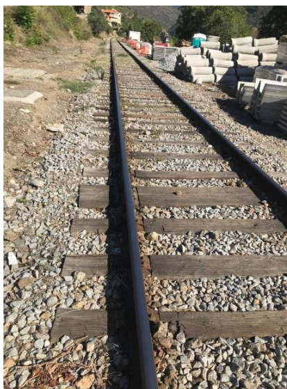
Figura A4.2 – Travessas existentes na Linha do Tua – via estreita (bitola 1000 mm).
