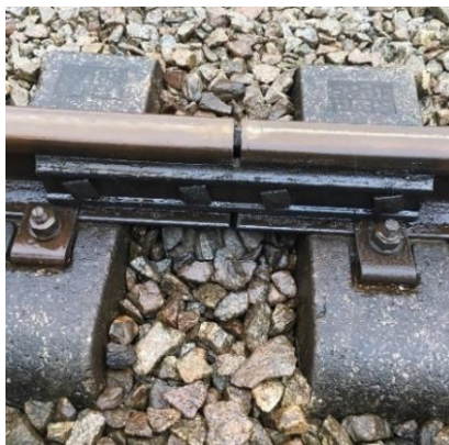
Figura 3.10 – Junta assente em travessas de betão presente no troço experimental.
