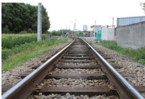
Figura 2.6 – Travessas de madeira.
