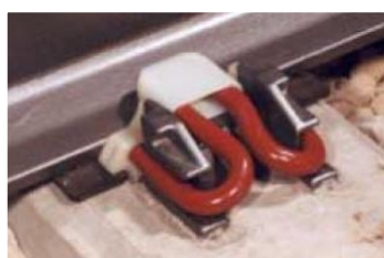
Figura 2.13 – Sistema de fixação Pandrol – fixação elástica (Esveld, 2001).
