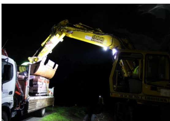
Figura A2.5 – Distribuição das travessas e fixação.
