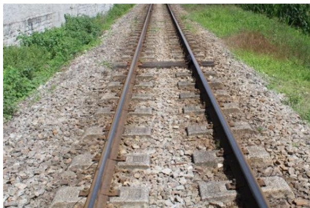
Figura 2.3 – Camada de balastro (Linha do Vouga).
