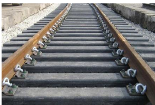
Figura 2.9 – Travessas de compósitos de polímeros (Falcão, 2013).
