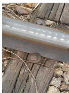
Figura 2.12 – Sistema de pregação rígida (Pires, 2018).
