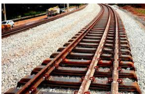
Figura 2.8 – Travessas metálicas (Moreira, 2014).
