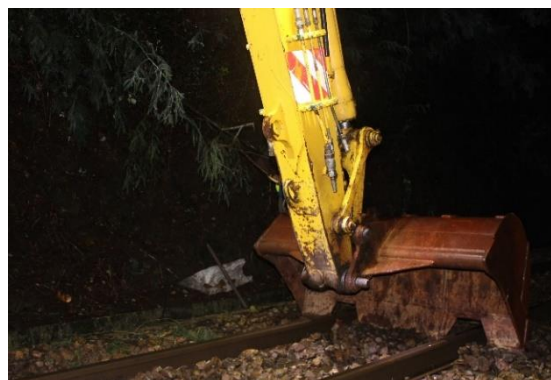
Figura A2.2 – Remoção do balastro.
