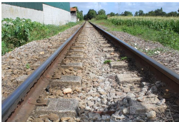
Figura 3.9 – Troço experimental localizado na Linha do Vouga entre o km 26+789 e o km 26+863.
