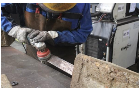
Figura 3.5 – Limpeza da cantoneira (desbravamento da corrosão).
