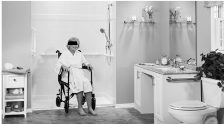
Figura 18 – Casa de banho adaptada a cadeira de rodas: espaço de circulação, móvel com espaço por baixo, chuveiro de fácil acesso (adaptado de https://www.eastersealstech.com/2014/06/11/top-5-things-consider-designing-accessible-bathroom-wheelchair-users/ )
