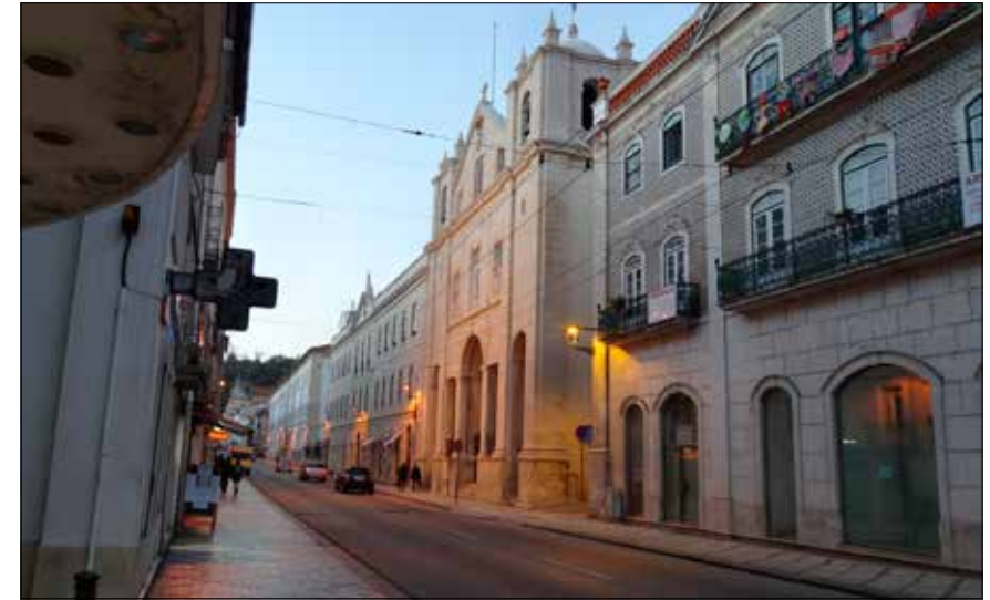
Imagem 6 – Edifício do Carmo (rua da Sofia, n.º 114, Coimbra)
