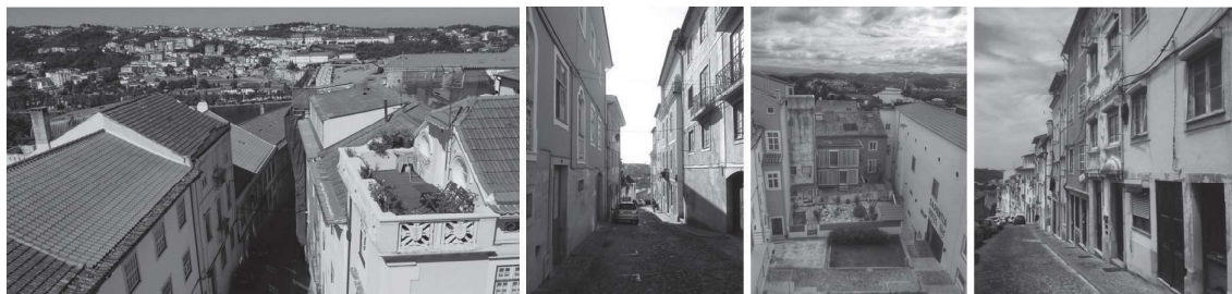
Fig. 4 – Exemplos de intervenção sobre o edificado urbano, ao longo da Calçada de Lisboa. Fotografia: Joana Capela de Campos, 2018.
