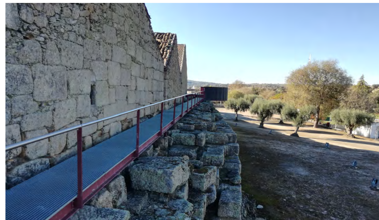
Figura 24: Intervenções em Idanha-a-Velha, realizadas no seguimento do programa das Aldeias Históricas de Portugal: percurso na muralha.
