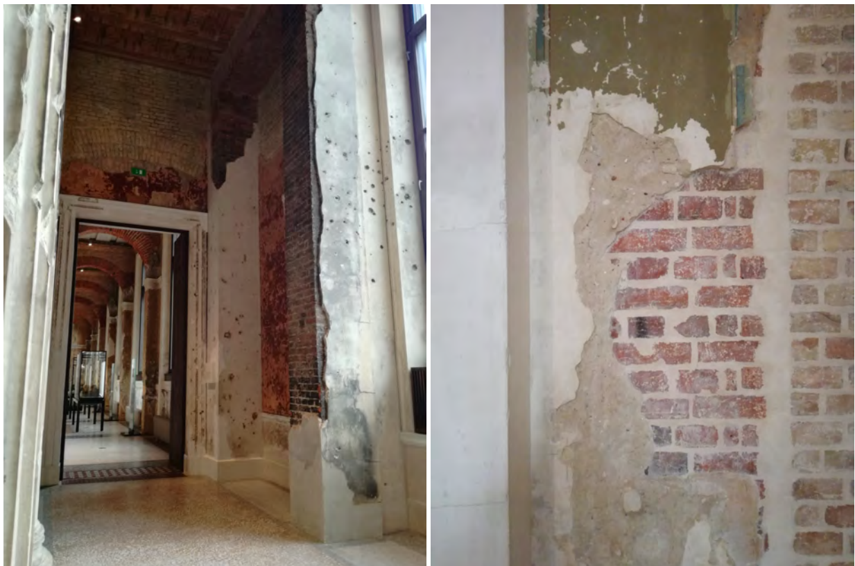
Figura 12: Zona da escadaria (à esquerda), detalhe do revestimento de uma parede (à direita), no Neues Museum, Berlim (fotog
