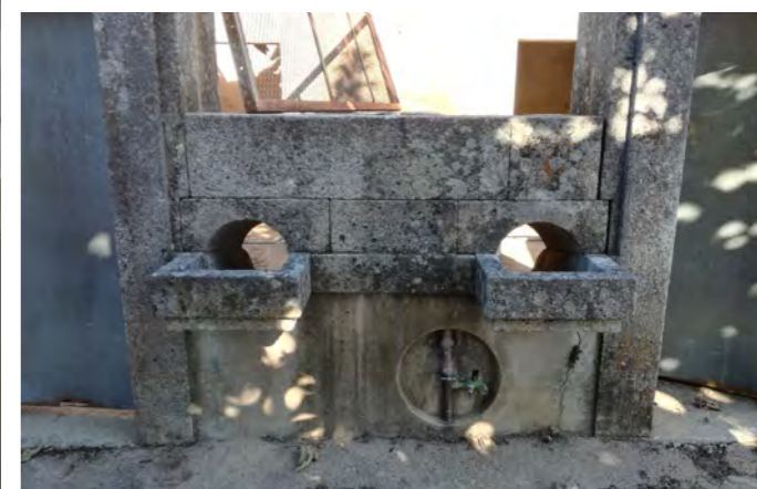
Figura 32: Vacarias e detalhe da pia do cortelho.
