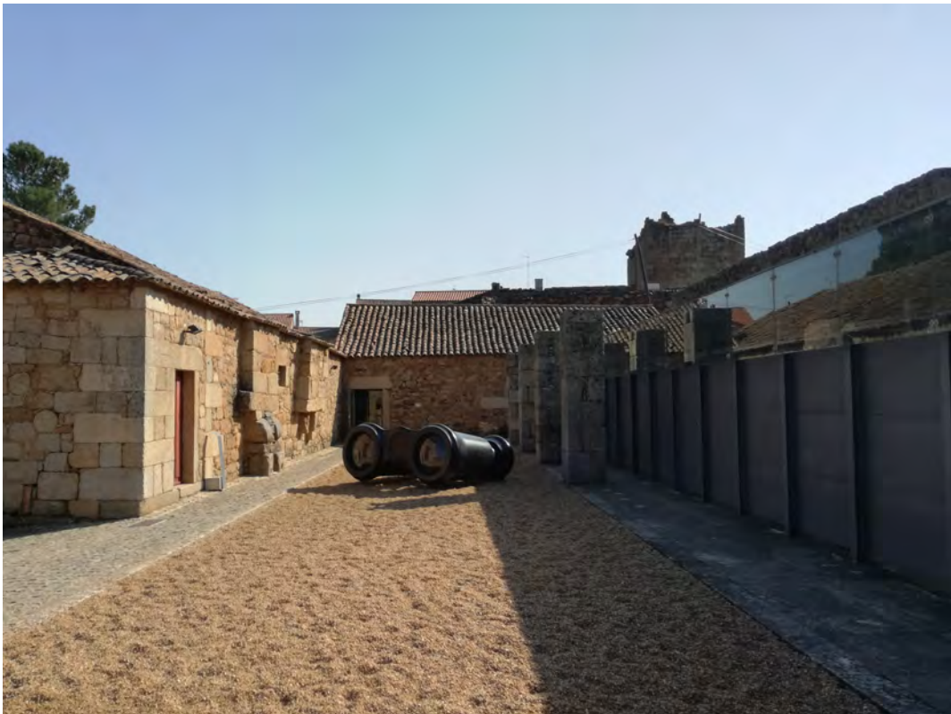
Figura 50: Intervenção do Atelier 15 em Idanha-a-Velha. Reconstrução do Lagar de Varas e construção do arquivo epi
