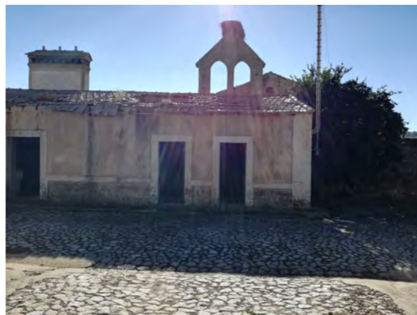
Figura 78: Zona de arrumos, cozinha e gerador.
