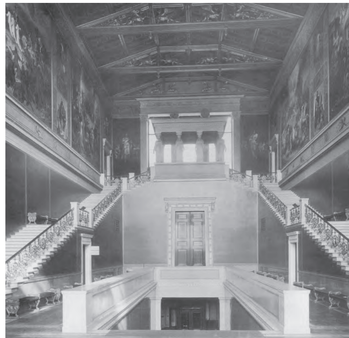
Figura 63: Escadaria do vestíbulo original (Da hitects, 2015).
