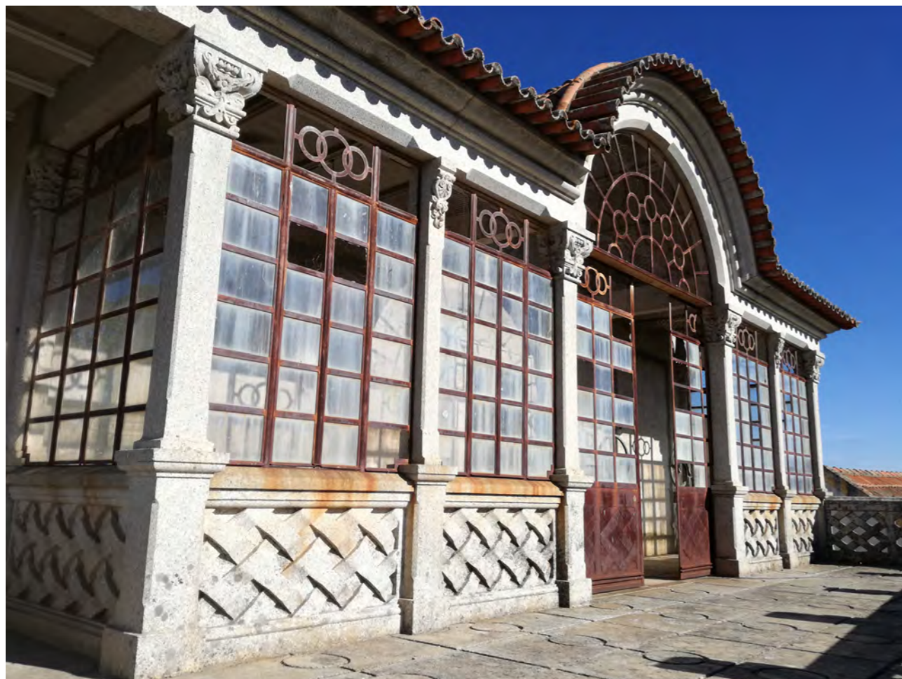
Figura 30: Varanda envidraçada no alçado lateral esquerdo (Sul).
