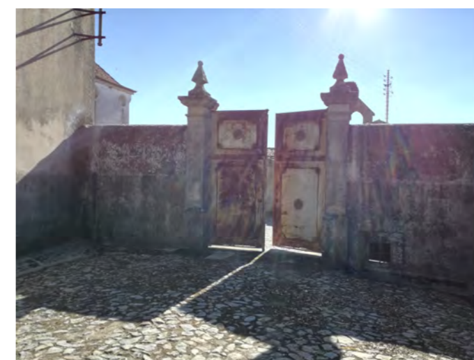
Figura 39: Portão de passagem entre pátio do trabalho e pátio dos animais.
