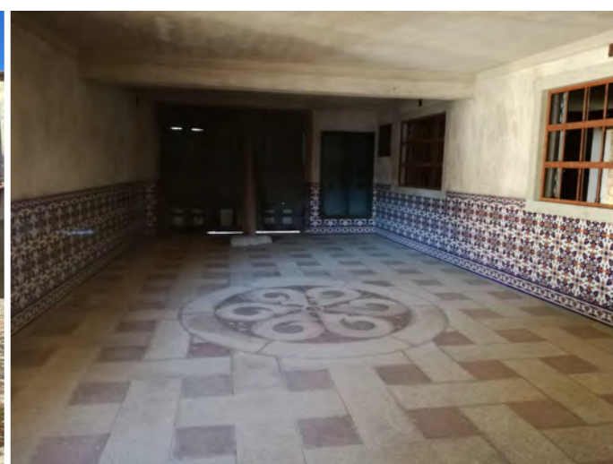
Figura 36: Detalhe do pavimento de cargas e descargas em granito.
