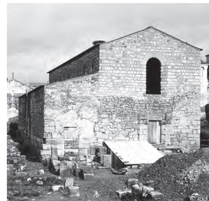
Figura 56: Alçado principal e batistério, após obras de restauro da DGEMN, 1964 (Conceição e Costa, 2010).
