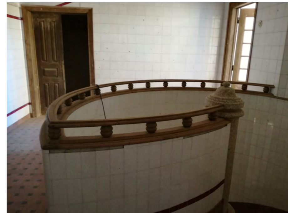
Figura 168: Escadas de acesso ao piso 3.
