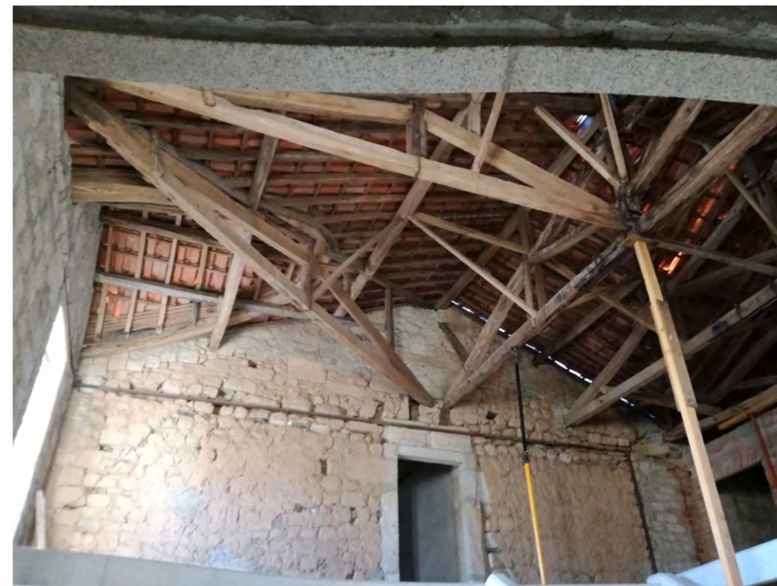
Figura 171: Estrutura da cobertura na zona do vestibulo do Solar.
