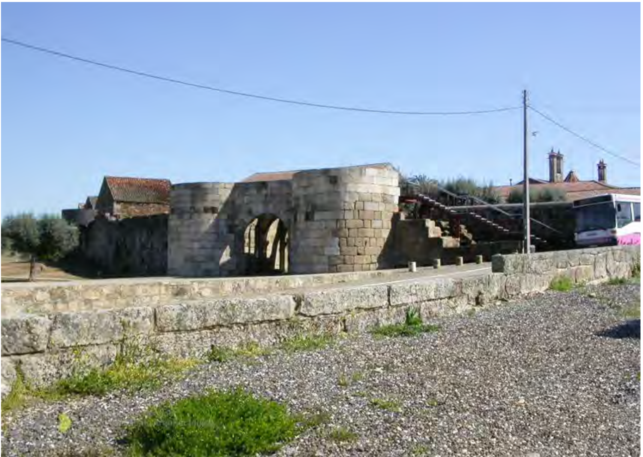
Figura 47: Intervenção do Atelier 15 na porta e muralha romana em Idanha-a-Velha. Antes (1994) e depois (2004) (Noé, 2016).
