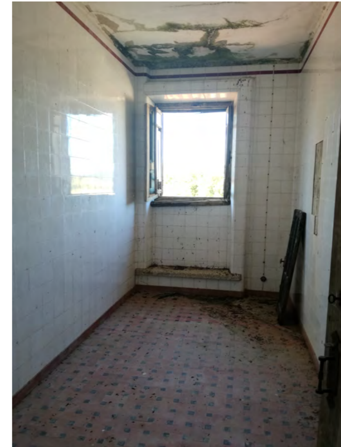
Figura 167: Quarto de funcionário no piso 3.
