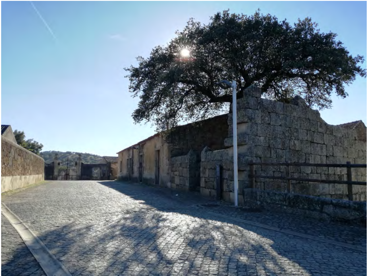
Figura 17: Entrada principal de Idanha-a-Velha. Ao fundo o muro de vedação e entrada para dependências agrícolas do Solar.
