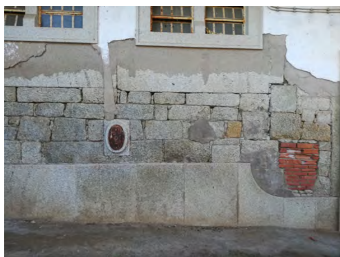
Figura 33 : Detalhe de parede exterior da Casa Nobre.
