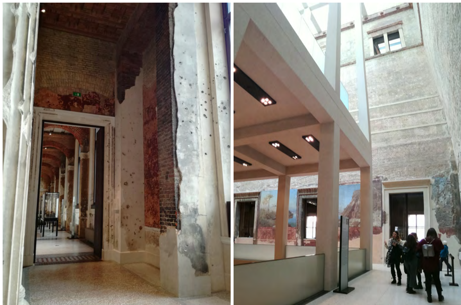
Figura 67: Espaços interiores do Neues Museum. Detalhes de revestimentos existentes e novos.
