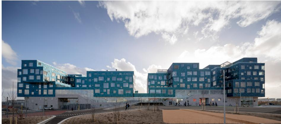
**Figura 8:** Fachada de um Edifício Composta por Células Solares [10]
