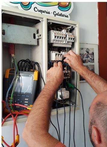
**Figura 12:** Instalação do Monitor de Consumo Energético
