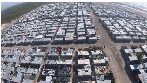
Figura 18 - Blikkiesdorp Vista de Drone
