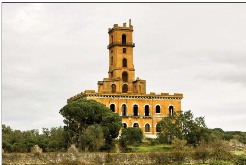
FIG. 2 – Edifício mandado erguer por Manuel Martins Gomes Júnior na zona de Coima (Barreiro).
