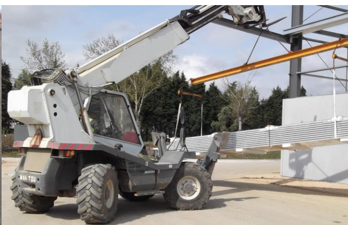
Figura 3.5 - Correta Manipulação de painéis sandwich de revestimento em estaleiro com o auxílio de vigas de equilíbrio
