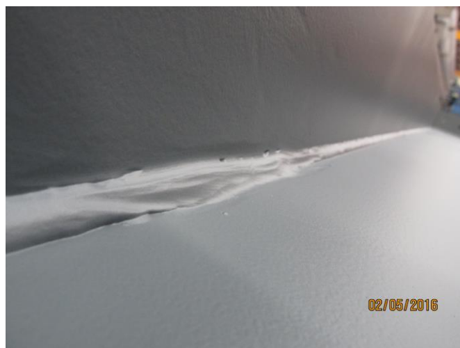
Figura 6.51 - Zona de cordão especialmente irregular com algum desbordo
