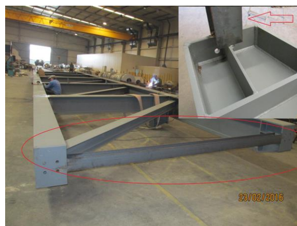
Figura 6.35 - Colocação de perfis tipo HE nos extremos de treliça metálica
