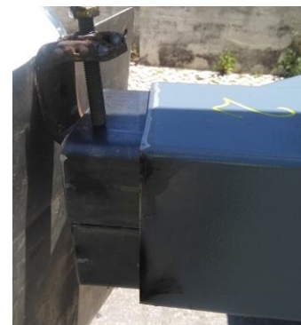
Figura 6.31 - Aplicação prática de “ backing strips ”
