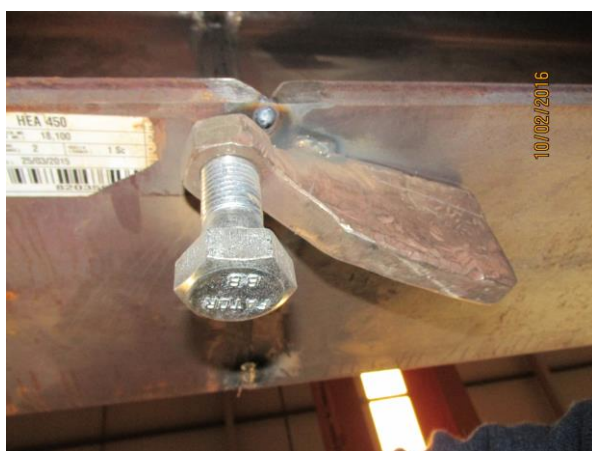
Figura 6.38 - Dispositivo rígido para auxiliar na soldadura topo a topo de perfil HEA 450
