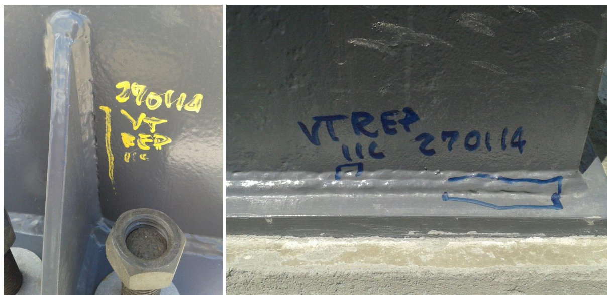
Figura 6.54 - Exemplo de bordos roídos em base de pilar
