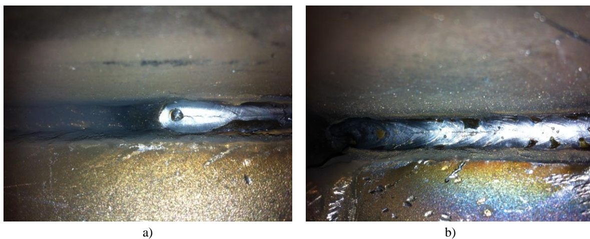
Figura 6.65 - Fissuração do cordão de raiz após a 1ª tentativa
