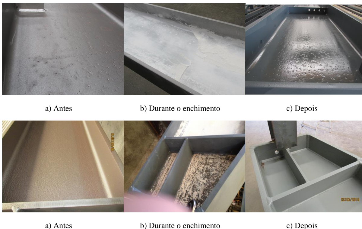
Figura 2.38 - Enchimento para reparação de covas e crateras superficiais
