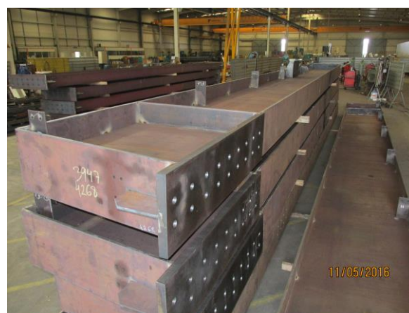
Figura 6.25 - Soldadura de pilares de alma cheia com h=1\text{ m} e L=10\text{ m}
