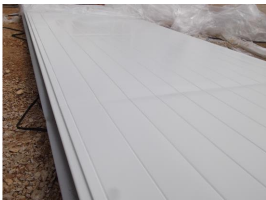
Figura 3.14 - Marcas transversais provocados pelos perfis de separação entre painéis.
