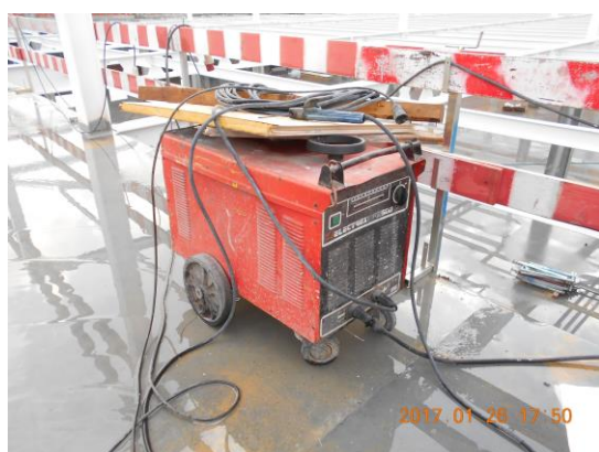
Figura 6.5 - Equipamento para soldadura com o processo SER
