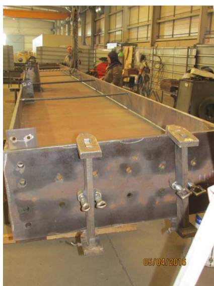
a) Preparação para soldadura
