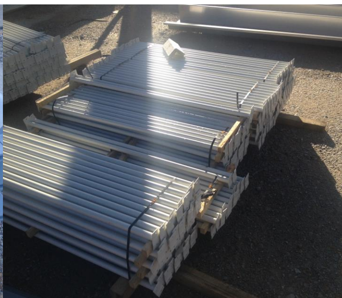
Figura 3.9 – Correto armazenamento em estaleiro
