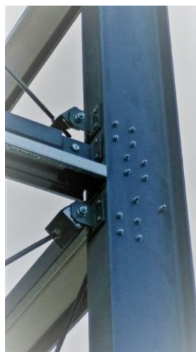
Figura 5.1 – Exemplo de ligações preferencialmente aparafusadas
