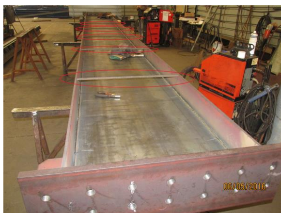
Figura 6.34 - Colocação de varões nervurados ao longo do perfil de alma cheia
