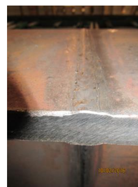
b) Corte e alisamento final
