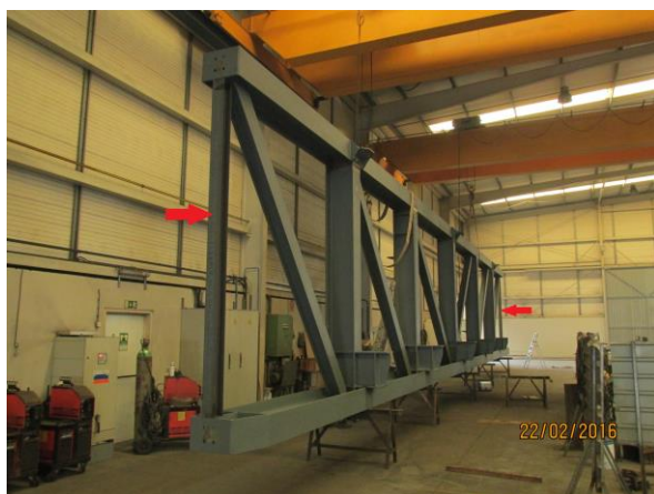
Figura 6.24 - Soldadura de uma “treliça” com dimensão de 24*4m
