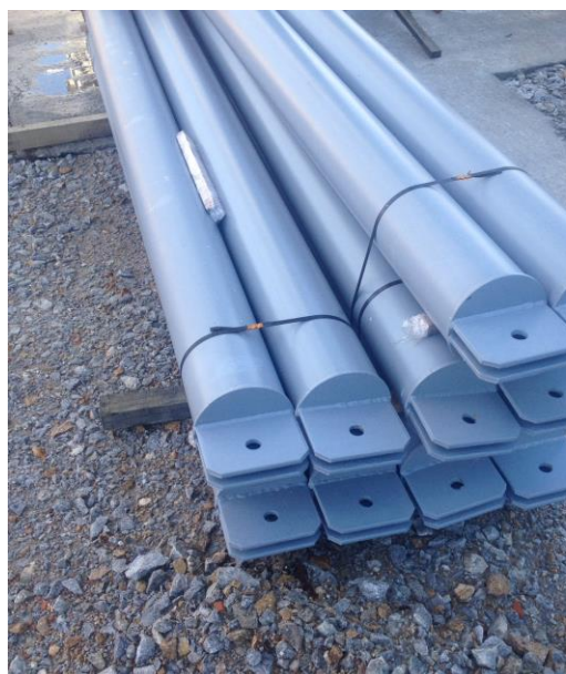
Figura 3.8 – Correto armazenamento em estaleiro
