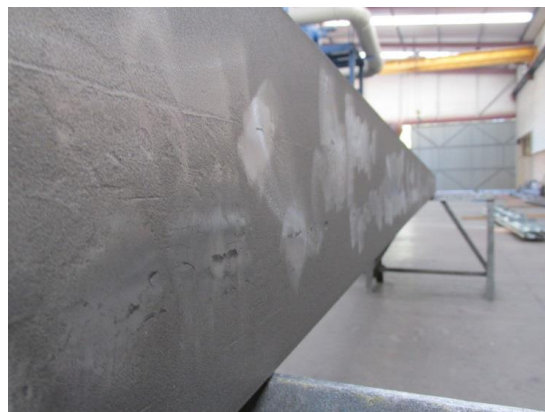
Figura 2.27 - Aspetto final do banzo da viga após retificação
