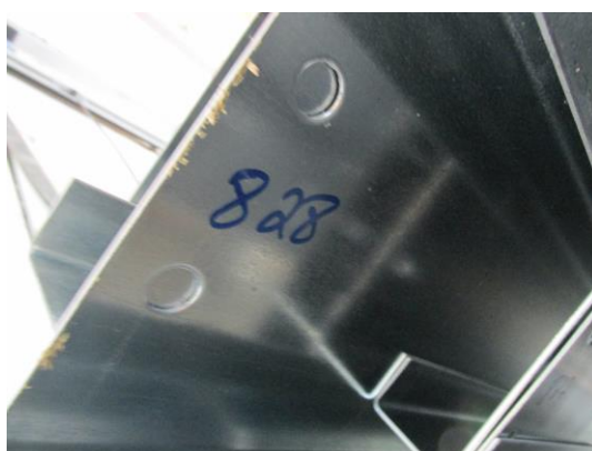
Figura 2.10 - Marcação de componentes em material galvanizado com marcador de tinta permanente
