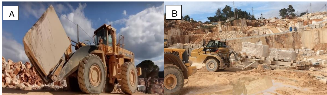
FIGURA 19-A) TRANSPORTE ASSEGURADO POR PÁ EMPILHADORA E B) TRANSPORTE ASSEGURADO POR GALERA
