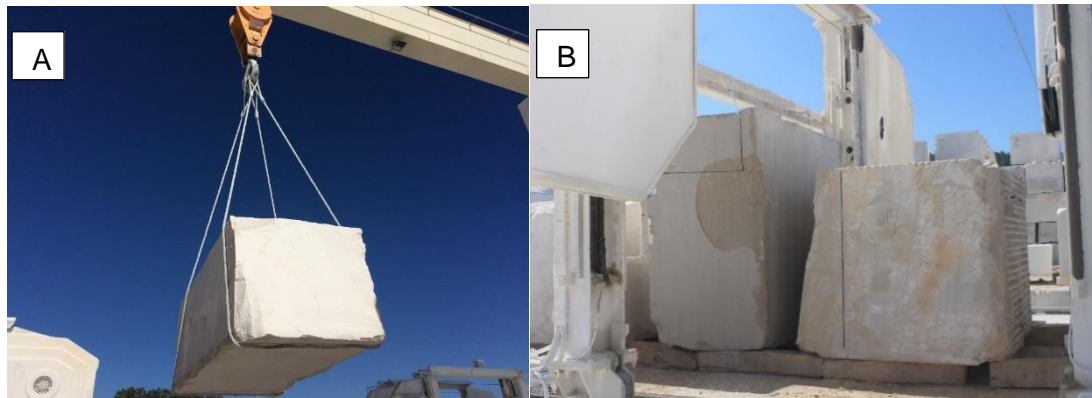
FIGURA 22 A) CABOS DE AÇO A ASSEGURAR O CORRETO TRANSPORTE DOS BLOCOS E B) CORTE DOS BLOCOS ATRAVÉS DAS MÁQUINAS DE FIO
