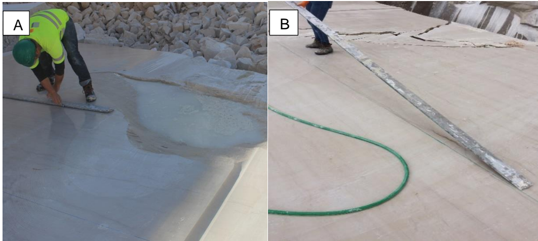
FIGURA 16-A) E B) MARCAÇÃO DOS LOCAIS PARA PERFURAÇÃO
