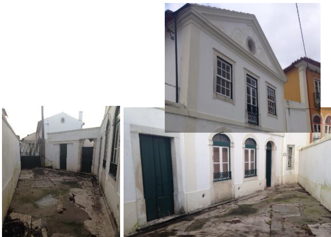
Figura 27 – Vista do pátio de chegada e alçado sudeste
