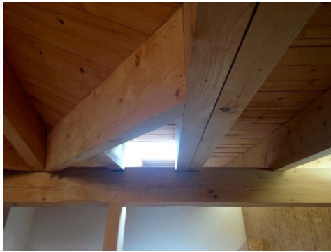
Figura 56 – Pormenor da cobertura
