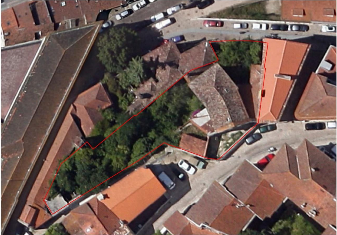
Figura 25 – Vista aérea do nº23 da Rua João Jacinto
