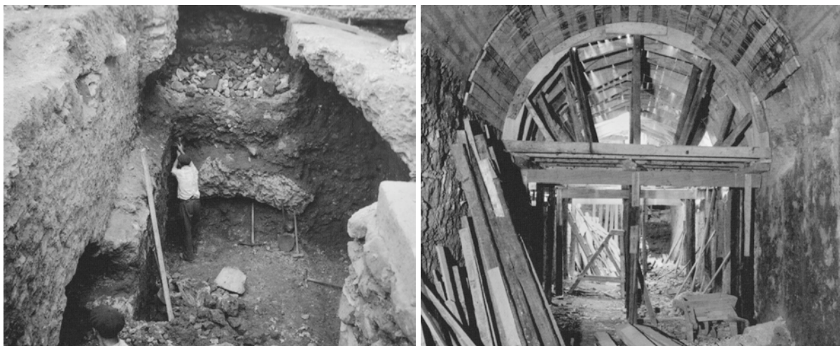
Figura 6.8 – Trabalhos de escavação e reconstrução da abóboda de uma das galerias do criptopórtico pela DGEMN. (Acervo Instituto dos Museus e da Conservação)
