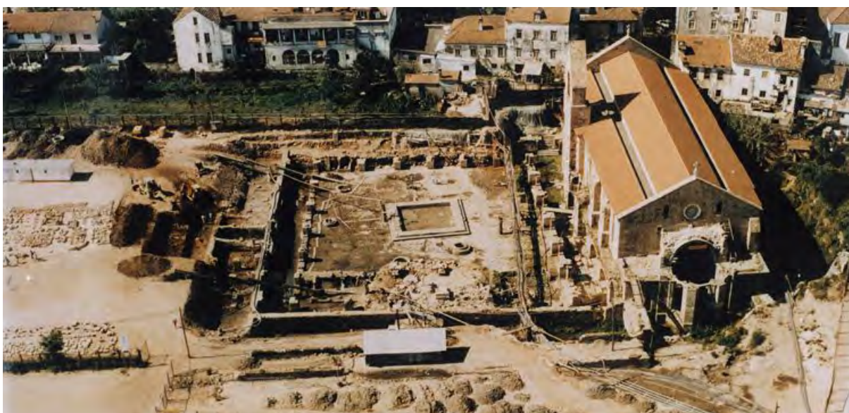
Figura 5.6 – Vista aérea do mosteiro durante as escavações. (IPPAR/Teixeira Duarte, 1998)
