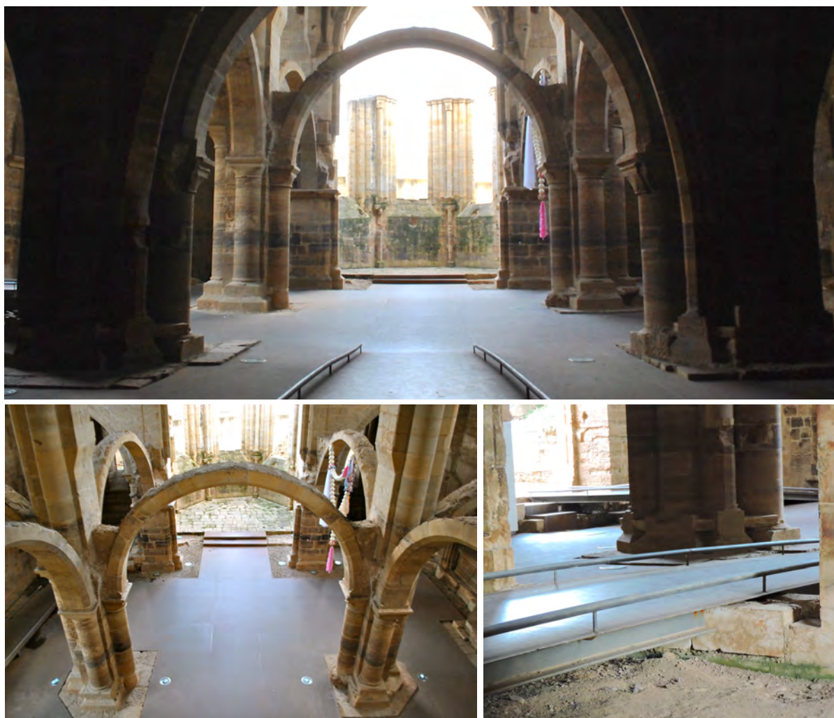
Figura 5.13 – Vista do interior da igreja e detalhes do pavimento e rampa de acesso em aço cortén. (Acervo pessoal, 2016-17)
