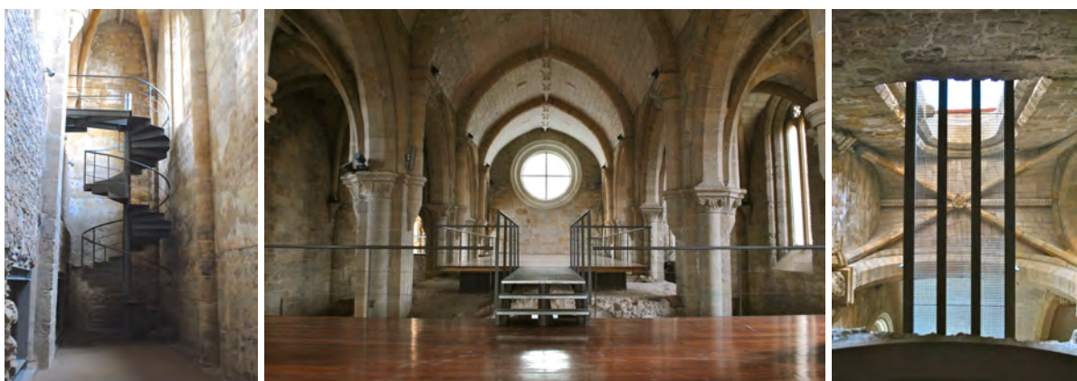
Figura 5.15 – Escada de acesso, estruturas e passadiços do piso superior. (Acervo pessoal, 2016)
