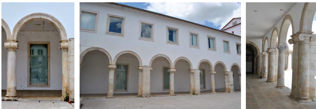
Figura 4.20 – O ritmo da fachada marcado pelos vãos preexistentes. (Acervo pessoal, 2017)
