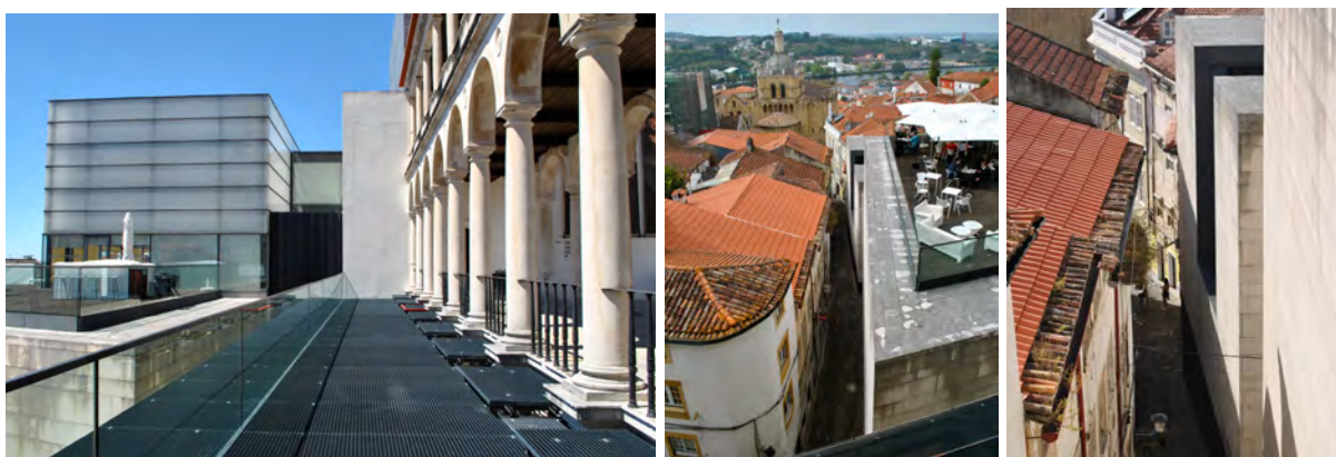
Figura 6.19 – O novo edifício com embasamento em pedra e parte superior em vidro, e a esplanada do restaurante com vista para o Mondego. (Acervo pessoal, 2016-17)
