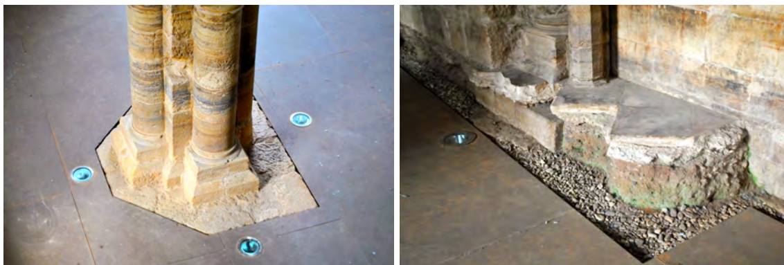
Figura 5.19 – Detalhes do encaixe das chapas de cortén com a preexistência. (Acervo pessoal, 2016)
