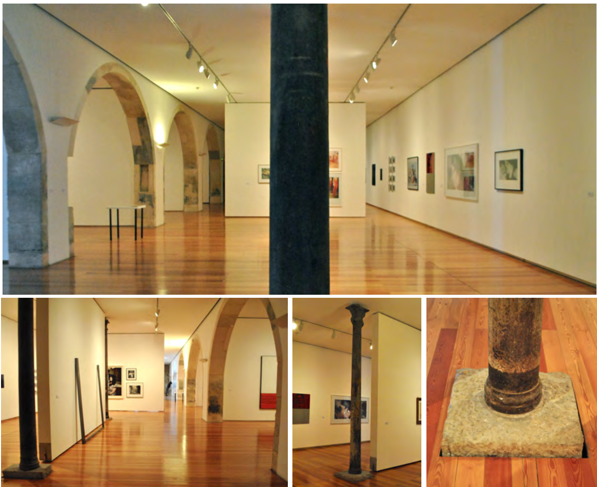
Figura 4.14 – Imagens do espaço expositivo do CAV no piso térreo e detalhe do recorte no pavimento de madeira para o embasamento da coluna de ferro fundido. (Acervo pessoal, 2017)
