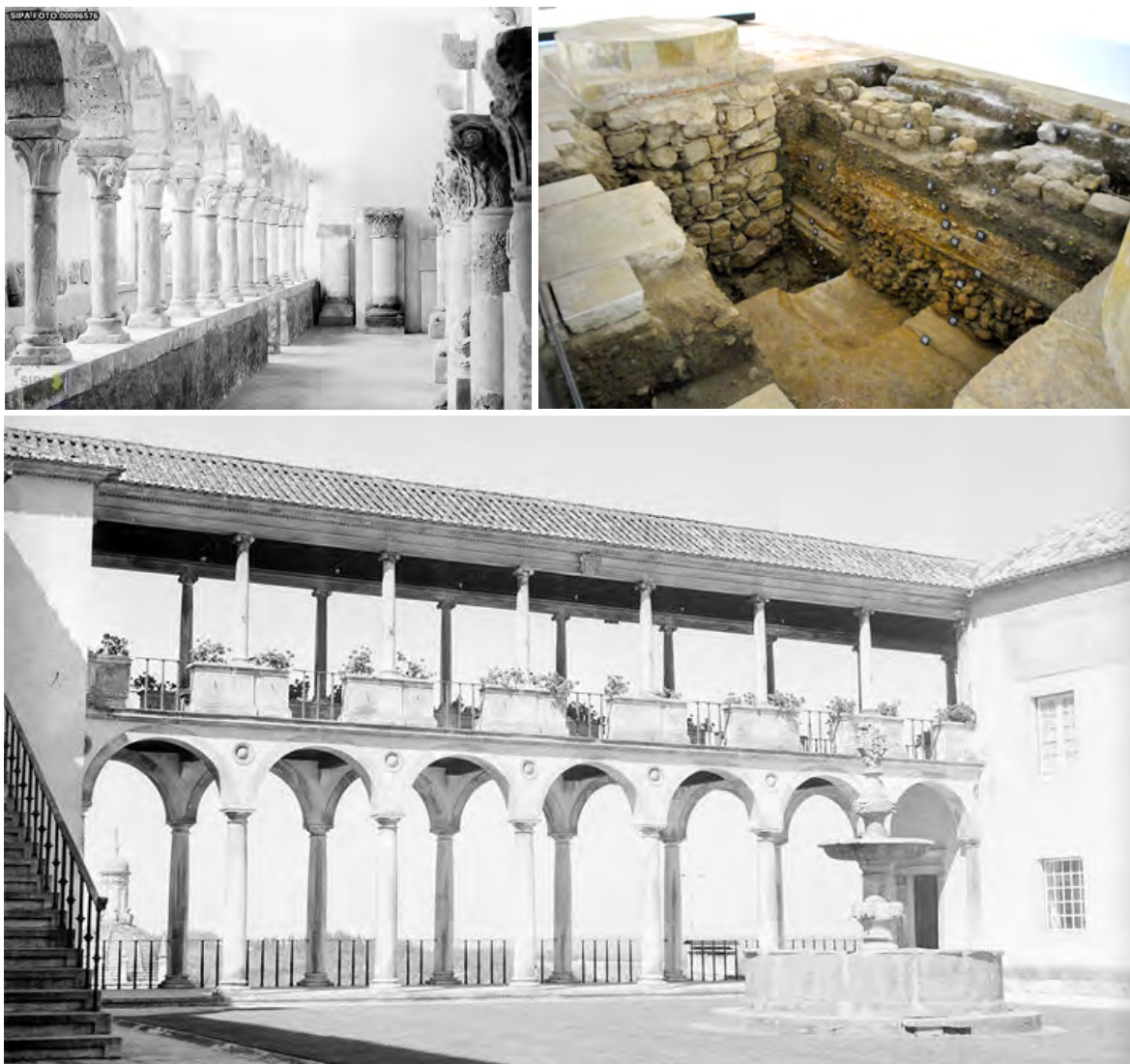
Figura 6.5 – Fragmentos do claustro da igreja pré-românica de S. João (Registo SIPA, 1939); embasamento dos pilares do templo românico (Acervo pessoal, 2016); e Loggia de Filippo Terzi (Registo SIPA, 1967).
