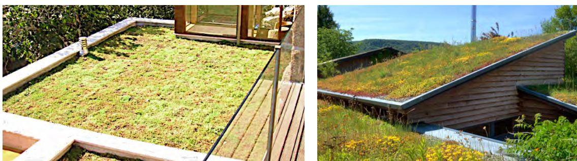
Figura 2.3 - Exemplos de coberturas extensivas: a) Cobertura verde extensiva plana, b) Cobertura verde extensiva com inclinação (Fonte: Landlab )
