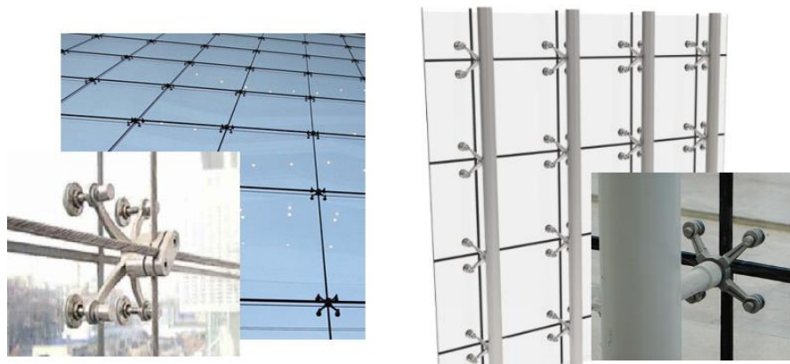
Figura 2.31 – “ Cable-Net ” (esquerda), “ Strongback ” (direita) (adaptado de [25] e [26]).
