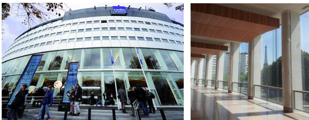
Figura 2.12 - Sistema “ Hahn ” do tipo “ Glass Fin ”, uma das primeiras “ Structural Glass Facade ” da história, utilizada na construção da “ Maison de la Radio ”, em Paris, em 1953 [72].
