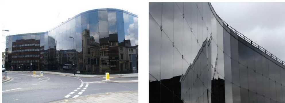
Figura 2.13 – Edifício Willis Faber & Dumas de dia [23].
