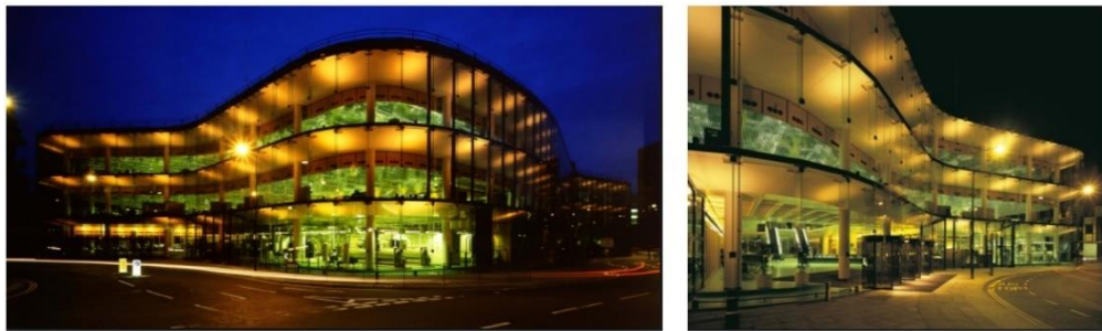
Figura 2.14 - Edifício Willis Faber & Dumas de noite [23].
