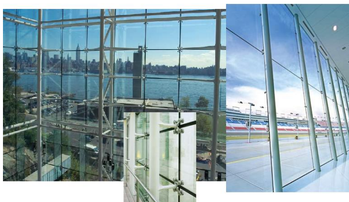
Figura 2.18 – Sistemas “ Strongback ” (adaptado de [13] e [70]).
