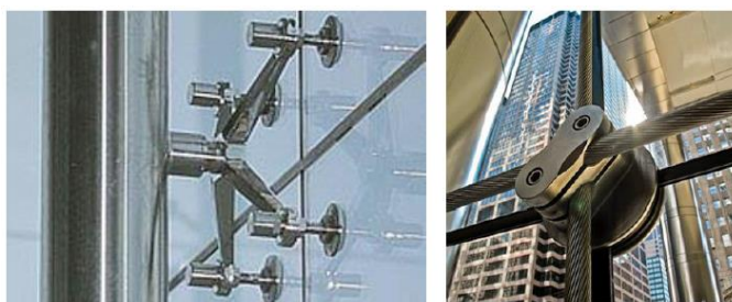
Figura 2.27 - “ Point-fixed bolted ” conectado a uma “ backer-structure ” do tipo “ Strongback ” com acessório de fixação de painel do tipo “ spider fitting ” (esquerda) e “ point-fixed clamped ” conectados a uma “ Cable-Net ” (direita) [70].
