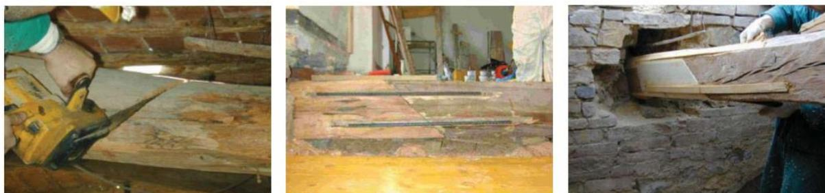
Figura 12 – Aplicação de CFRP em viga deteriorada (SCHOBBER et al., 2015).
