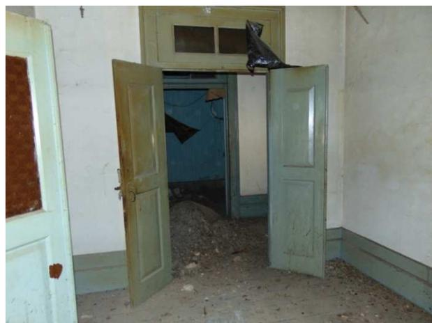
Figura 03: Vista interna do quarto com piso, rodapé e porta de duas folhas com bandeira.
