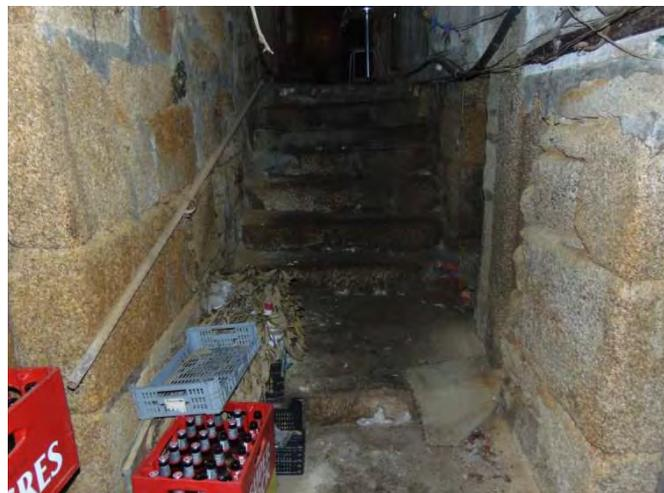
Figura 02: Corredor localizado na cave do edifício, constituído por alvenaria estrutural de pedras. Ao fundo, a escada retilínea para acesso ao piso térreo.
