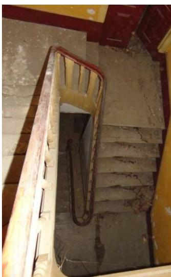
Figura 04: Vista da bomba da escada, com a continuação do corrimão de madeira. Destaque para os degraus isolados após o patim de acesso ao fogo 04.
