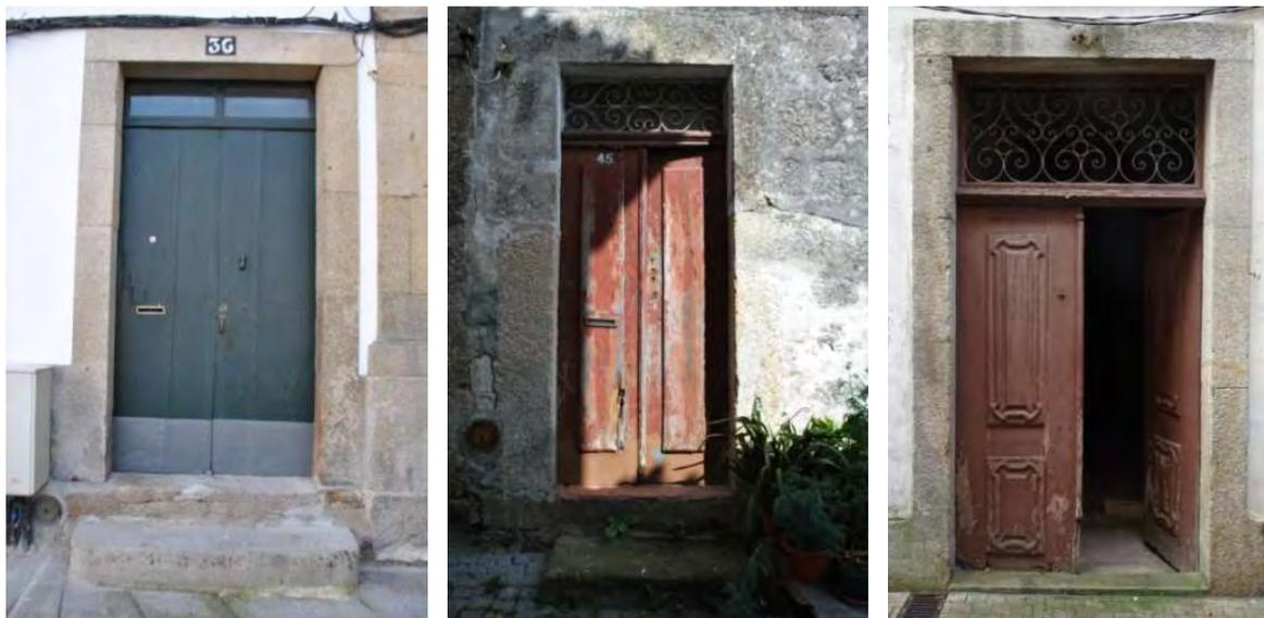
Figura 3.7: Destaque para os ressaltos e degraus nas LMIS036, RCHM045 e RDIR120.
