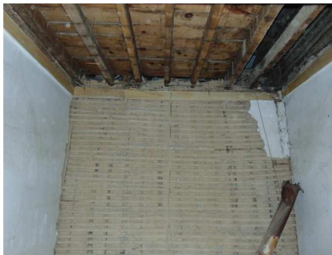
Figura 02: Vista interna do quarto com a divisória de tabique sem revestimento.
