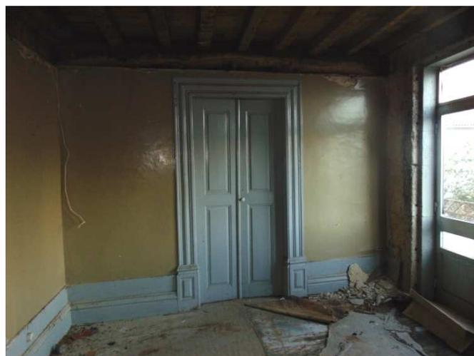
Figura 03: Parede interna de tabique com porta de duas folhas que dá acesso ao quarto 01.
