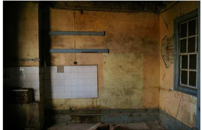
Figura 02: Vista da parede de divisa de alvenaria de pedra parcialmente revestida de azulejo.
