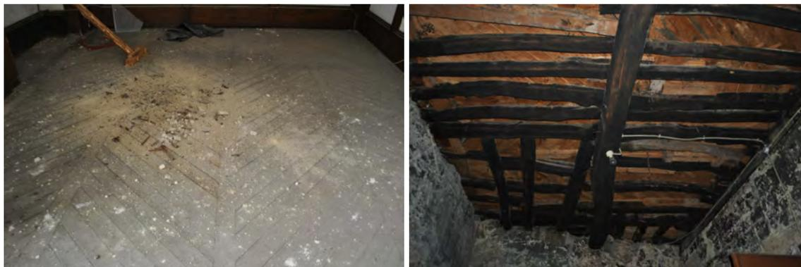
Figura 3.34: Assoalho e estrutura do piso da RDIR160.
