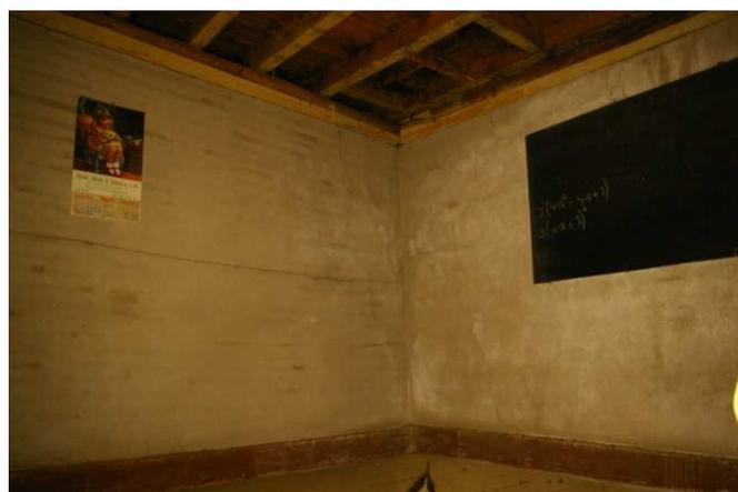
Figura 03: Interior do compartimento com piso de madeira, alvenaria de tabique e estrutura do teto de madeira sem forro.
