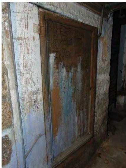
Figura 02: Vista da porta de madeira com destaque para o desnível com relação ao piso do corredor.
