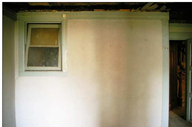
Figura 02: Vista interna da sala de jantar, com alvenaria de tabique. À direita o acesso ao hall de entrada e a instalação sanitária.
