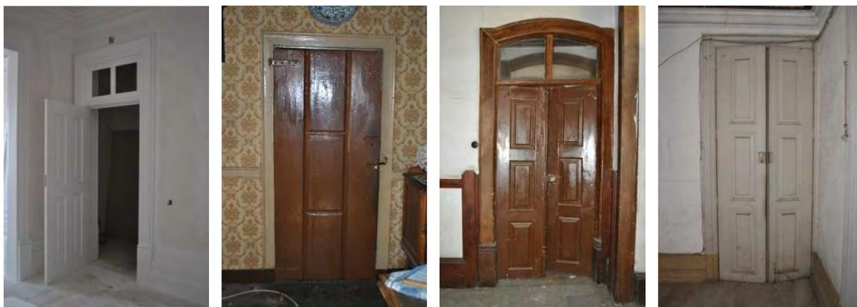
Figura 3.35: Portas internas de uma e duas folhas das edificações RADR005, RDIR160, RDIR166 e RAUC011.
