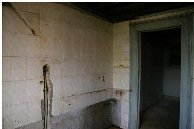
Figura 02: Revestimento cerâmico na parede da cozinha com falta de partes, sujidades, fissuras e quebras.
