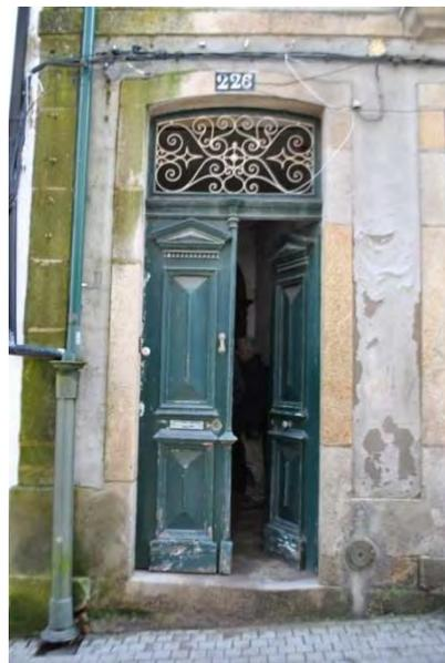
Figura 02: Vista do acesso a edificação multifamiliar e ao átrio. A entrada apresenta desnível médio de 0,275m, porta de duas folhas tendo cada uma 0,485m.
