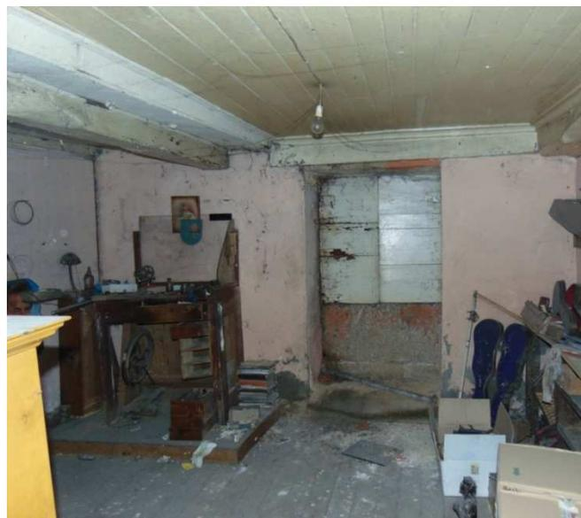
Figura 02: Sala de estar com acúmulo de objetos. Piso e teto em madeira, parede externa em pedra e divisões em madeira.
