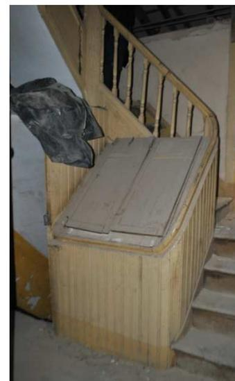
Figura 06: Abertura zenital da bomba da escada. Vista interna do fogo 05 e, à esquerda, o vão de acesso ao lance inferior, no qual há uma porta de abrir com uma folha de madeira.
