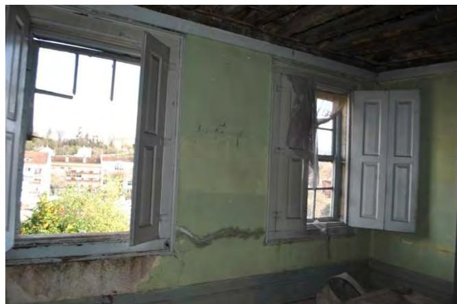
Figura 02: Janelas de madeira em precárias condições de conservação.
