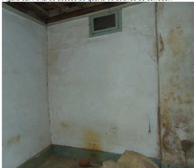
Figura 03: Vista interna do quarto 03, com destaque para a parede de alvenaria de pedra com pequena abertura próximo do teto.
