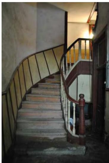
Figura 02: Escada arqueada presente no rés-do-chão, com o primeiro degrau em pedra e os demais em madeira. Na lateral direita há corrimão de madeira e na lateral esquerda revestimento sobre a alvenaria.
