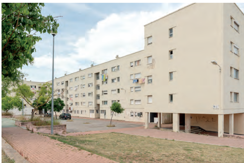
FIG. 4 PIZ, Parque do Casal do Zambujal, 2018 (edifícios projetados por equipa dos arquitetos Vítor Figueiredo e Duarte Cabral de Mello para o FFH, 1975-1977). Arquivo do IHRU
