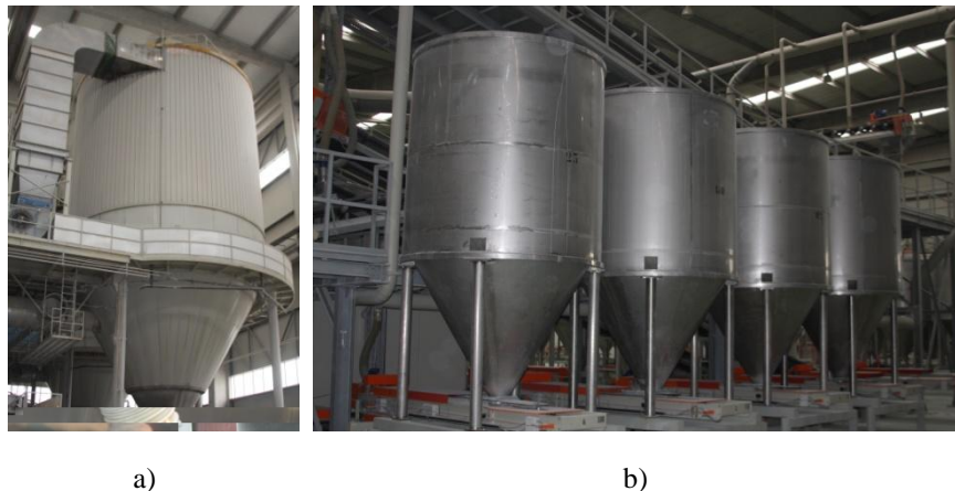
Figura 3.5 – Etapa de atomização e armazenamento do pó: a) Atomizador b) Silos de armazenamento de pó
