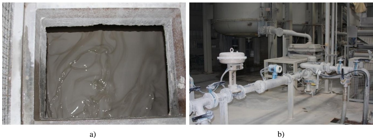
Figura 3.4 – Transporte da pasta: a) Pasta em transporte ; b) Tubagens destinadas a conduzir a pasta
