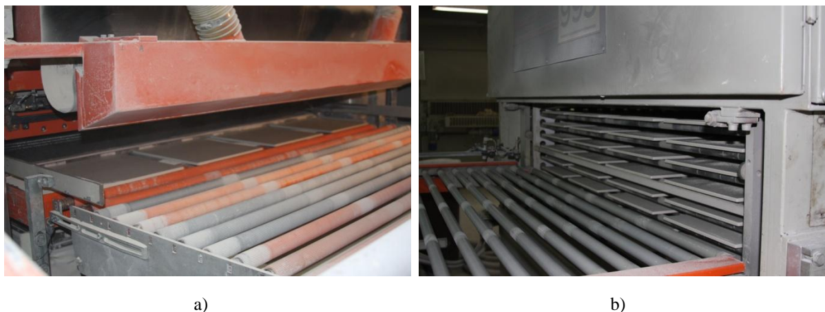
Figura 3.6 – Prensagem e secagem dos ladrilhos: a) Prensa hidráulica ; b) Secador
