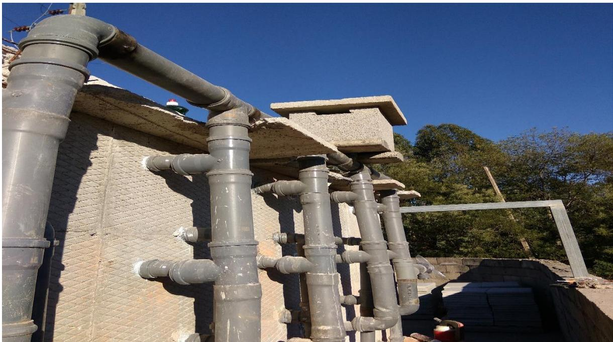
**Figura 1.2-** Redes independentes para ventilação e lixiviados.
