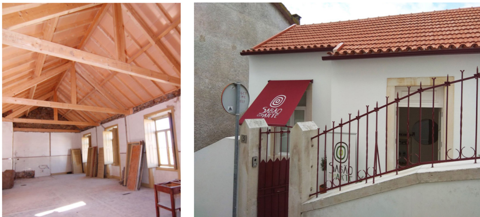
Figuras 42 e 43: Obras realizadas nas instalações da Sabão com Arte
