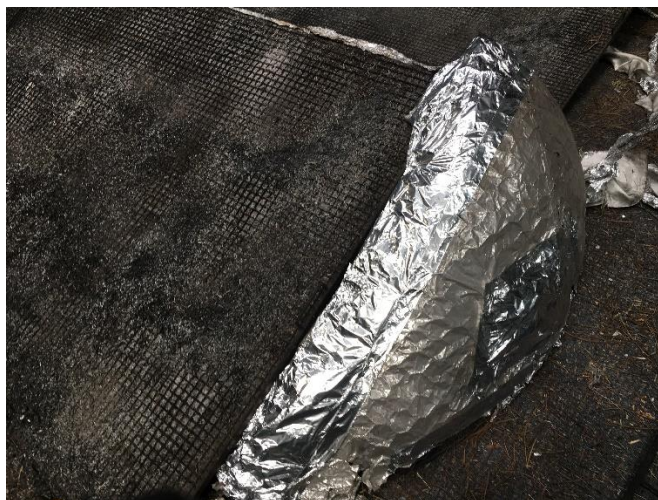
Figura 7 - Estrutura redonda junta à colina
