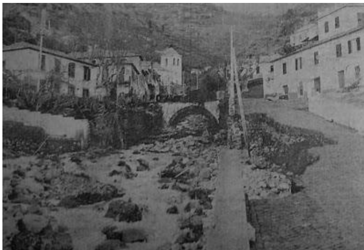
Figura 33 - Destruição provocada pela cheia e inundação na ribeira da Calheta em 1979, vista de Sul
