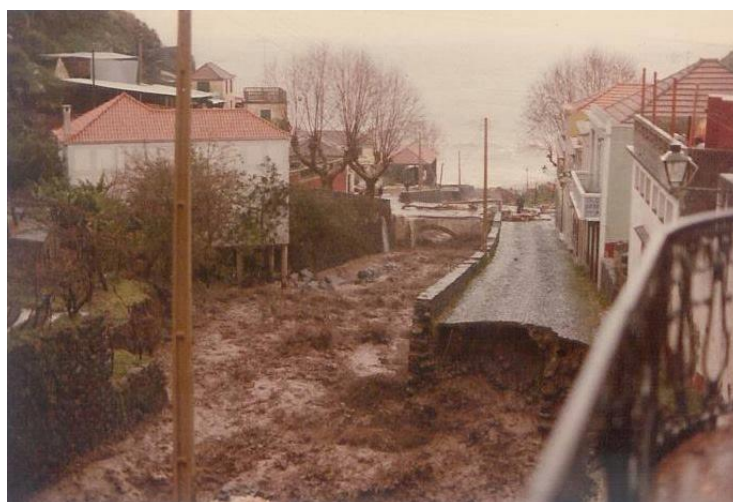
Figura 34 - Destruição provocada pela cheia e inundação na ribeira da Calheta em 1979, vista de Norte
