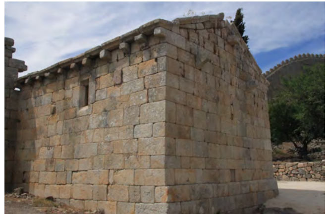
Foto 179 a 180: Pormenores arquitetónicos da antiga matriz de Santa Maria - Castelo de Numão - Vila Nova de Foz Côa
