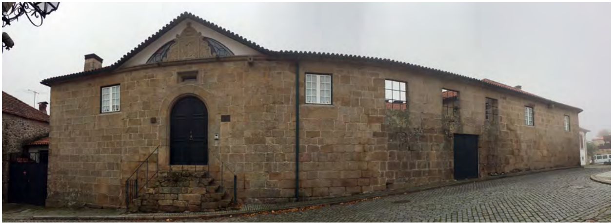
Foto 223: Casa da Comenda de Malta - Sernancelhe
