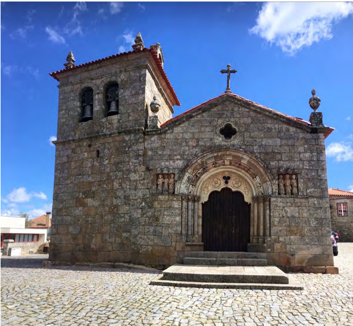
Foto 175: Fachada da matriz de São João Batista - Sernancelhe
