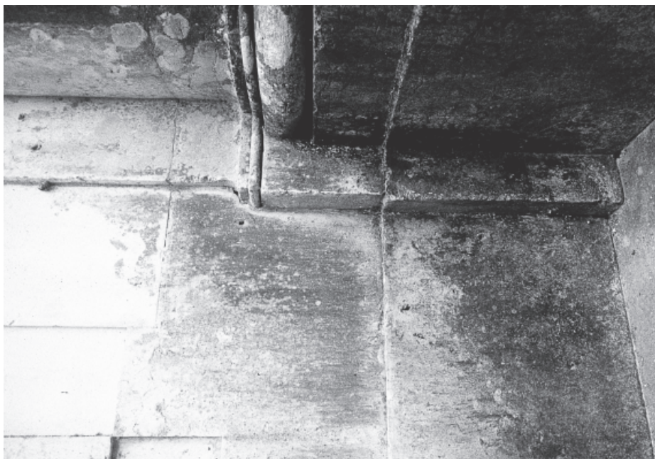
57 e 58. Pormenores do muro separador evidenciando a sua construção posterior.
