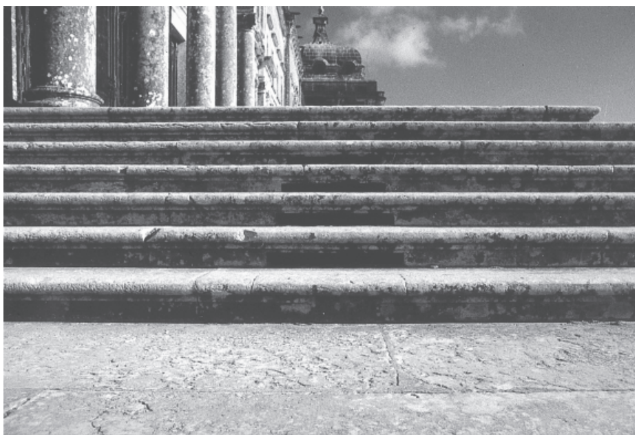
83. Aspecto da plataforma de acesso à Basílica vendo-se, nos degraus do patim superior, as pequenas frestas de arejamento do carneiro monástico.
