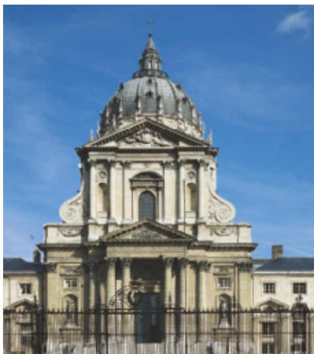
Façade de l'église du Val-de-Grâce, Paris. © Deneux/Agence TOP.
