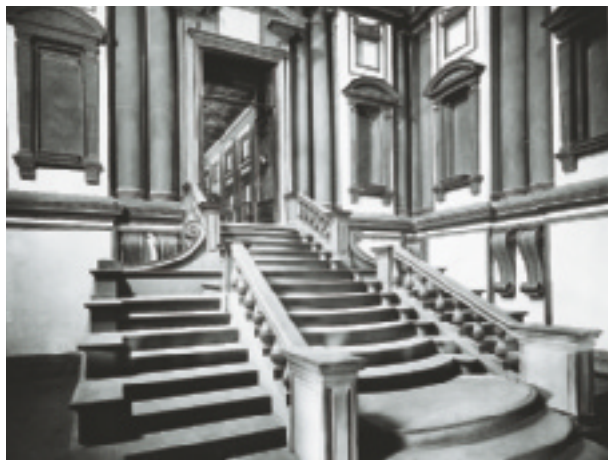
MICHEL-ANGE (1475-1564) et Giorgio VASARI (1511-1574), vestibule et escalier de la bibliothèque Laurentienne à Florence. © Alinari/Giraudon.
