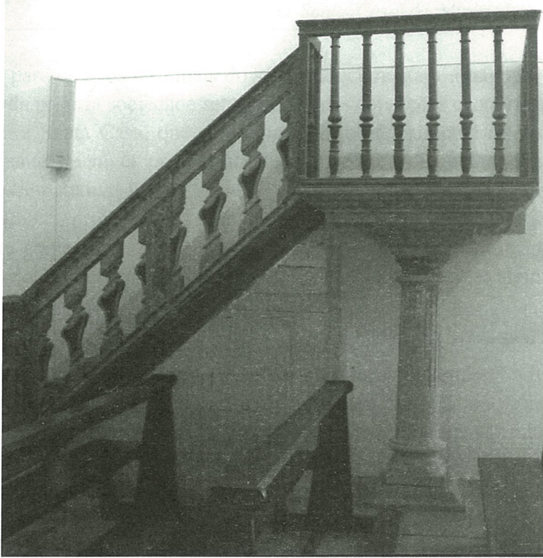
Interior da Igreja: O púlpito, com grade, assenta sobre uma coluna dórica canelada. Em baixo, a imponente tribuna dos mesários, com colunas dóricas de fustes lisos e a sacada de madeira com balaústres.
