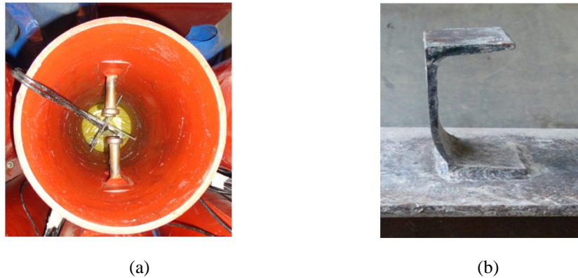
Figura 2.19 - Conectores de cisalhamento mais usuais: (a) conectores pinos com cabeça; (b) conector perfil U (Maleki e Baghri, 2008).
