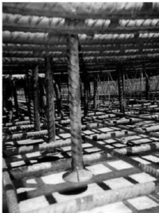
Слика 1. 3 Пример можданика постављених преко горње арматуре за савијање [7 стр. 2]
