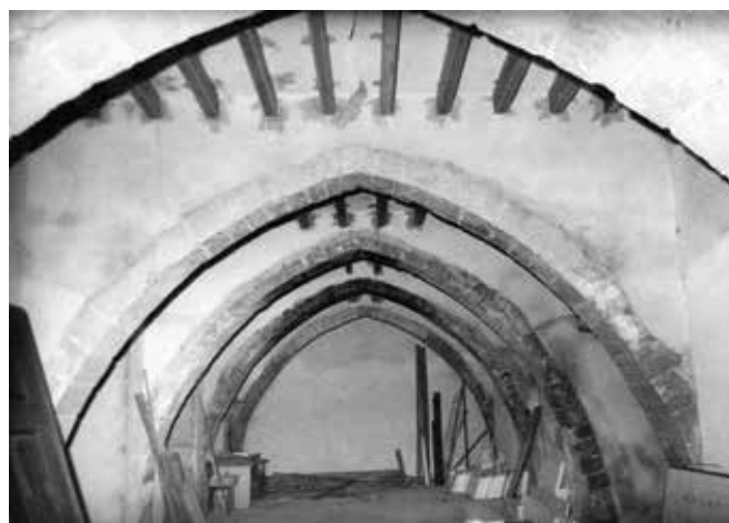
Aspecto da sequência de arcos quebrados vistos do piso térreo (DGEMN, foto 734)
