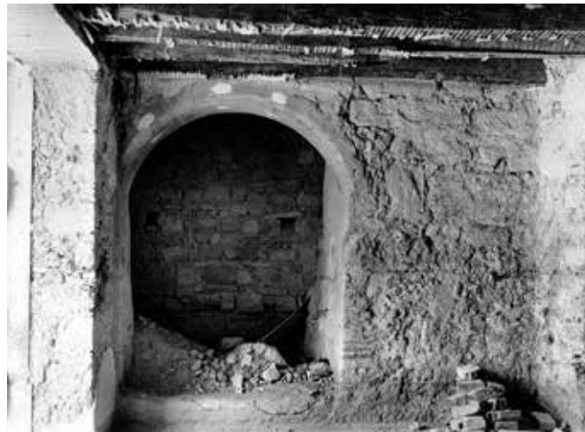
Arco manuelino localizado na Casa dos Arquivos , junto ao cubelo sul da portaforte (DGEMN, foto 114).
