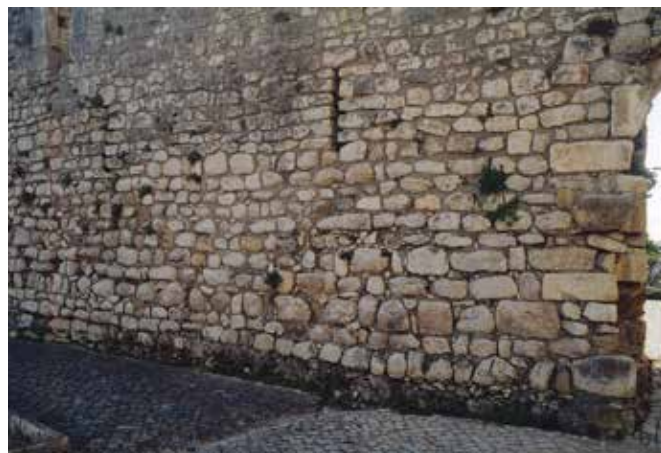
Aspecto da muralha sul e respectiva torre (Nuno Santos).
