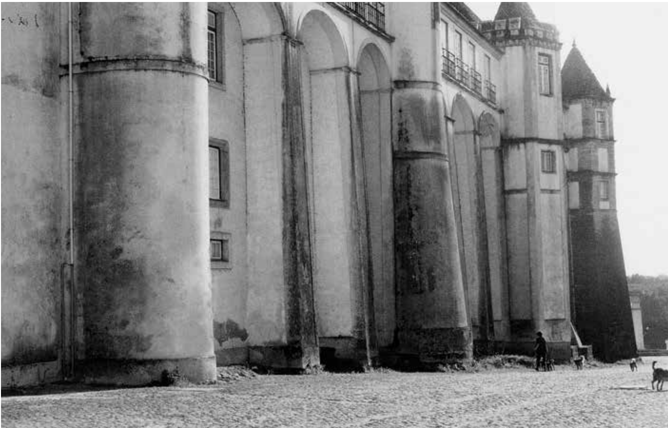
Perspectiva da fachada norte após o rebaixamento dos terrenos.
