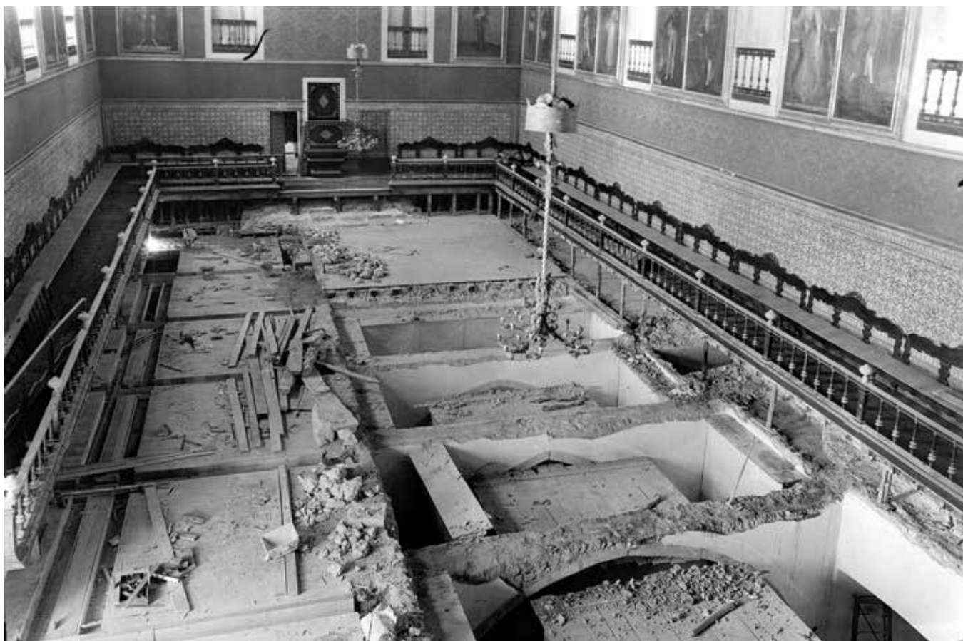
Aspecto da Sala dos Capelos após a remoção do pavimento, em 1944, ostentando a parede intermédia e a sequência de arcos quebrados do piso térreo (DGEMN, foto 3-0020)
