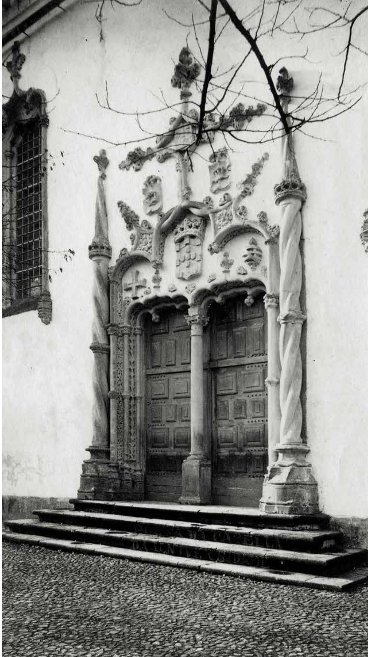
Aspecto do portal antes da remoção do mainel (DGEMN, foto 87)
