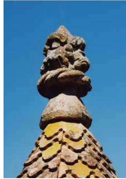
Coroamento do 2º cubelo (sentido este/oeste).
