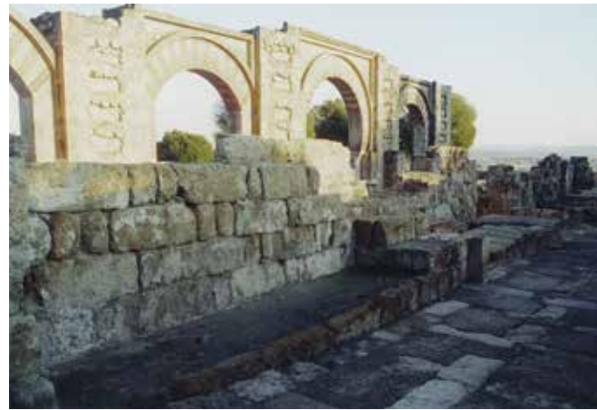
Aspecto das muralhas de Mérida, ilustrando a reutilização, em grande extensão, dos silhares romanos provenientes das muralhas destruídas.
