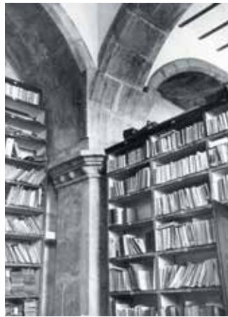
Aspecto dos arcos incorporados no depósito da antiga sala de leitura da Biblioteca da Universidade (DGEMN, foto 154).
