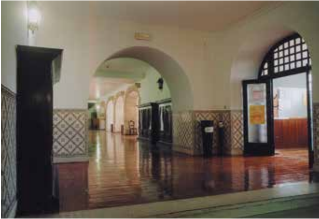
Arco transverso de sustentação da parede oriental da Sala Grande.
