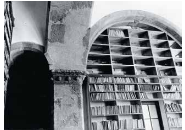
Outro aspecto dos referidos arcos, vendo-se um dos pequenos arcos de ligação ao paredão do albacar edificados por Silva Pinto (DGEMN, foto 156).
