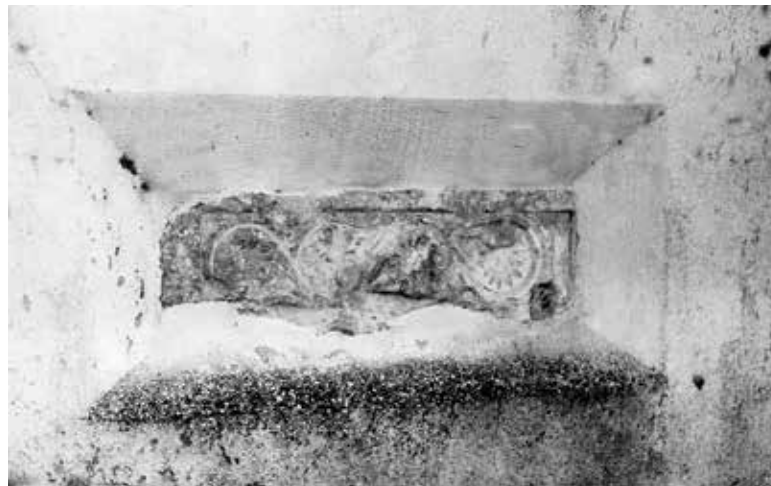
Aspecto da pedra visigótica localizada na fachada norte em 1945.
