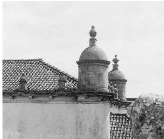
Cornija modilhonada da Capela dos Reis Magos da Igreja do Mosteiro de S. Marcos.
