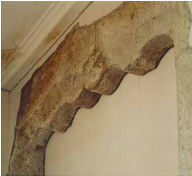
Primitivo vão de acesso ao interior do nível superior do 2º cubelo da fachada norte (sentido este/oeste).
