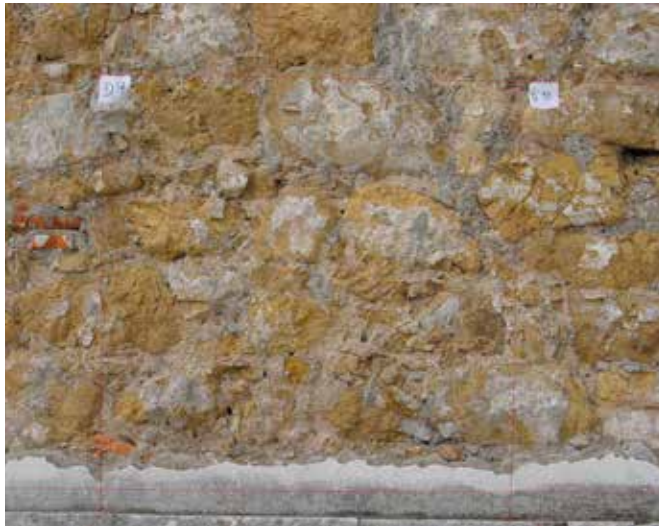
Aspecto do aparelho utilizado no registo inferior esquerdo da sondagem G1 (foto Nuno Santos).
