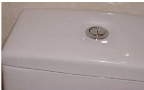
Figura A. 4 - Autoclismo de dupla descarga (Ecocasa).
