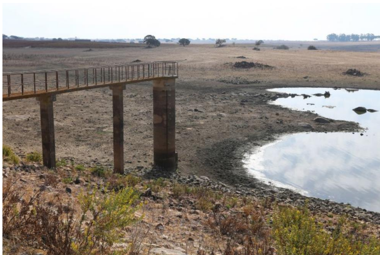
Figura 5 - Barragem de Fagilde em outubro de 2017 (Pontos de Vista, 2017).
