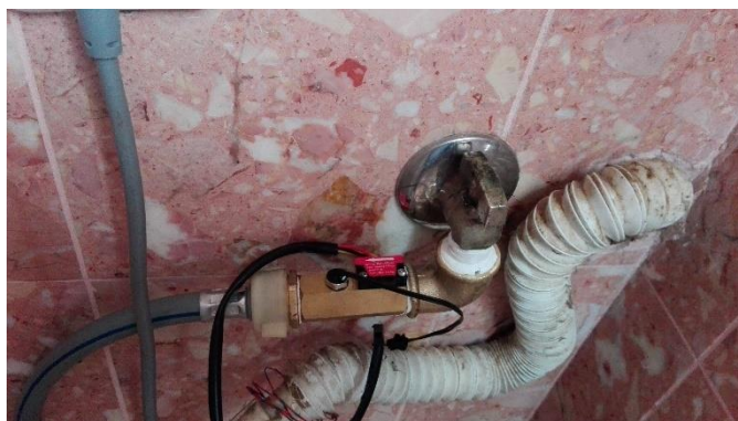
Figura AP. 28 - Instalação do sensor de caudal para a máquina de lavar roupa (edifício de habitação 3).
