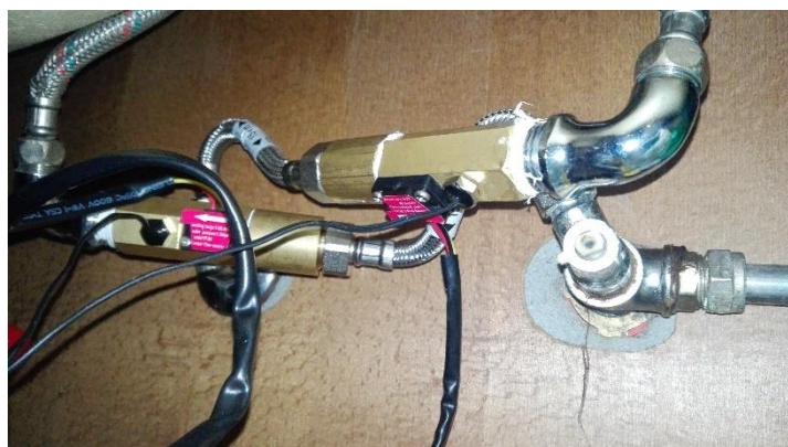
Figura AP. 30 - Instalação do sensor de caudal para o lava loiça (edifício de habitação 3).
