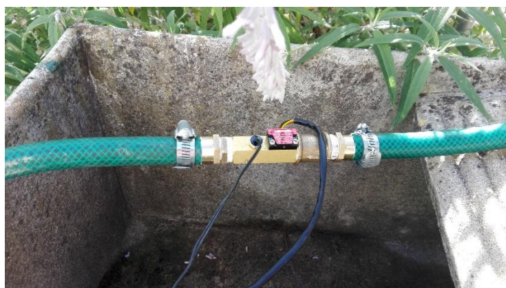
Figura AP. 29 - Instalação do sensor de caudal para a rega do jardim (edifício de habitação 1).
